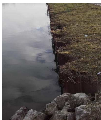
Illustration 8. Berges en palplanche Source : Dossier VNF
