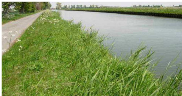
Illustration 2. Bordure d'hélophytes (Roseau commun) installé sur une berge bétonnée dégradée
