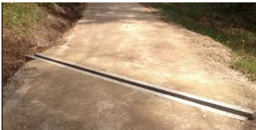
Figure 5 : Exemple de pose de renvoi d'eau après remblaiement de la couche de roulement.
