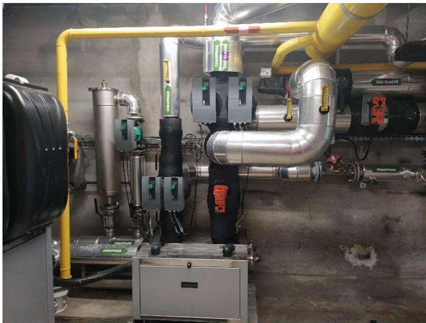
Fig.9 – Départs des circuits de chauffage et change-over
