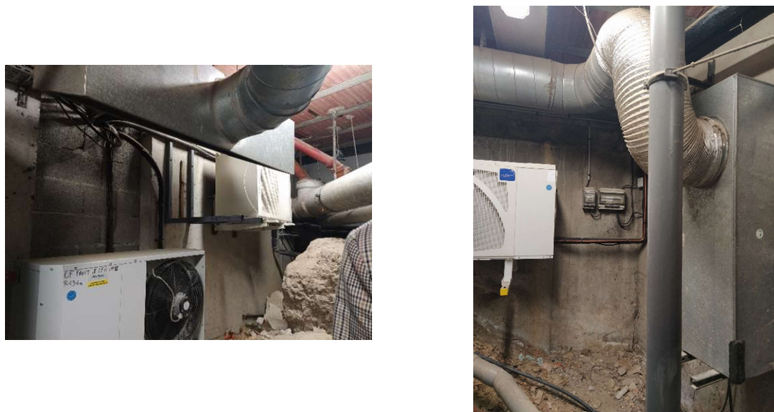
Fig.31 – Caissons d'extraction dans le vide sanitaire
