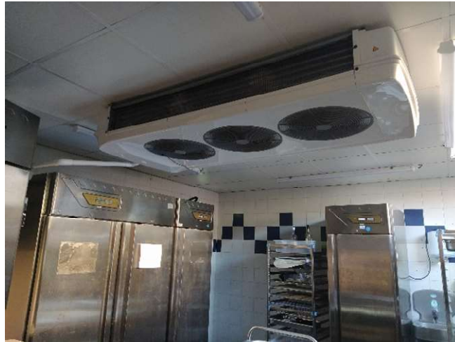
Fig.26 – Unité intérieure PROFROID préparation froide cuisine
