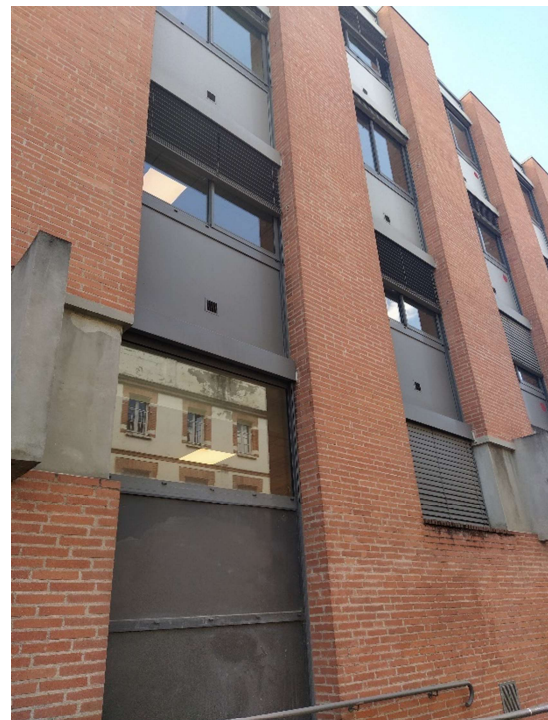
Fig.2 – Panneaux sandwich rénovés – côté rue
