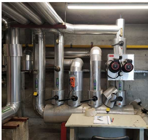
Fig.16 – Départs des circuits de refroidissement
