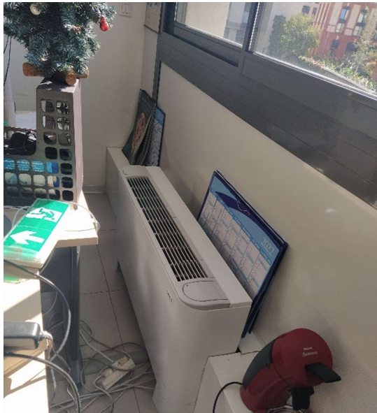
Fig.10 – Ventilo-convecteurs 2 tubes dans les bureaux
