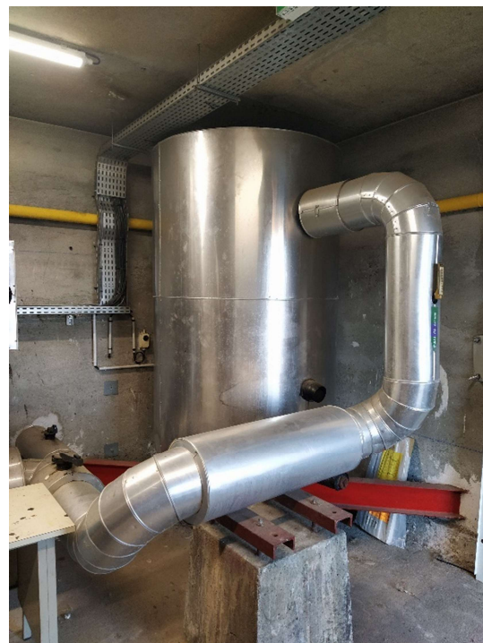
Fig.17 – Ballon tampon eau glacée
