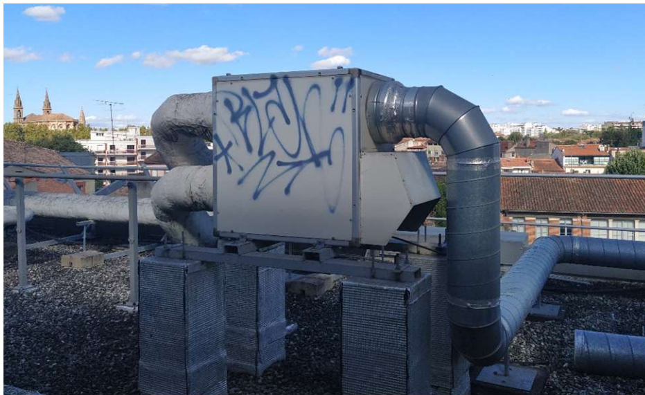
Fig.29 – CTA Double flux ALDES – salles de réunion sous-sol
