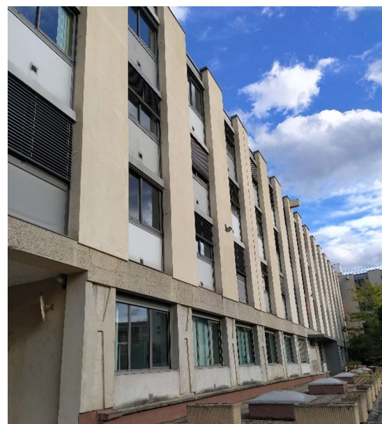
Fig.3 – Panneaux sandwich et menuiseries rénovés – côté cour
