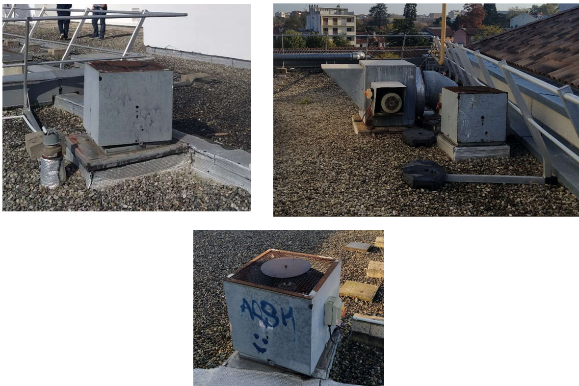
Fig.30 – Caissons d'extraction en toiture
