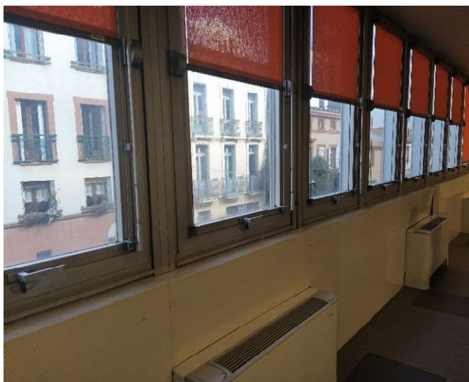
Fig.4 – Occultation par store intérieur – mur rideau
