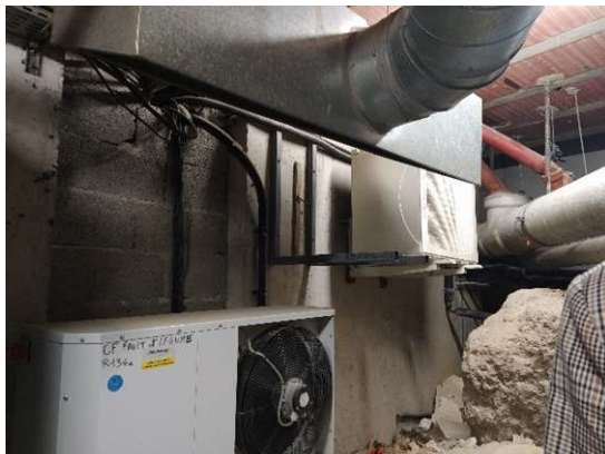
Fig.27 – Unités extérieures climatisation cuisine
