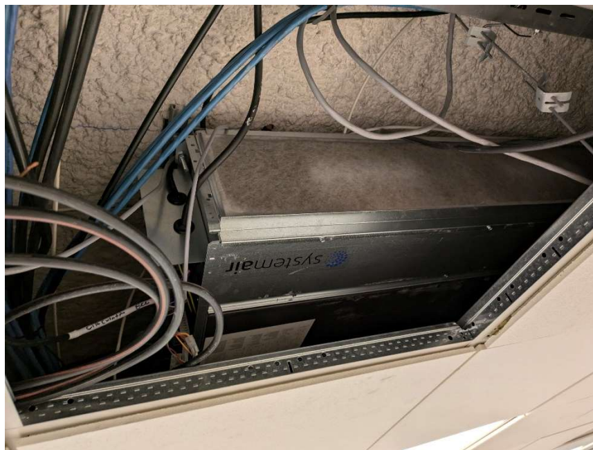
Fig.12 – Ventilo-convecteur gainable 4 tubes dans la salle Lautrec
