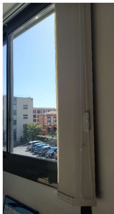
Fig.6 – Occultation supplémentaire par stores intérieurs – ensemble des menuiseries rénovées orientées Sud
