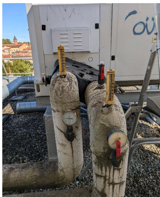
Fig.19 – Réseau primaire du GF Lennox
