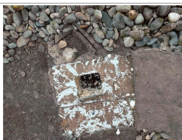
Prélèvement - P010 : TOITURE 1 - Pare-vapeur- (Absence d'amiante)
