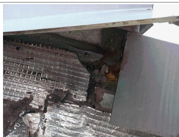
Prélèvement - P012 : TOITURE 3 - Mastic- (Absence d'amiante)
