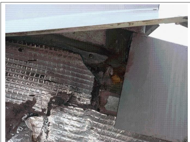
Prélèvement - P013 : TOITURE 3 - Bardeau bitumineux- (Absence d'amiante)
