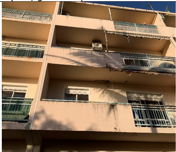
façade ouest éclats de béton déjà réparé, garde-corps rouillés
