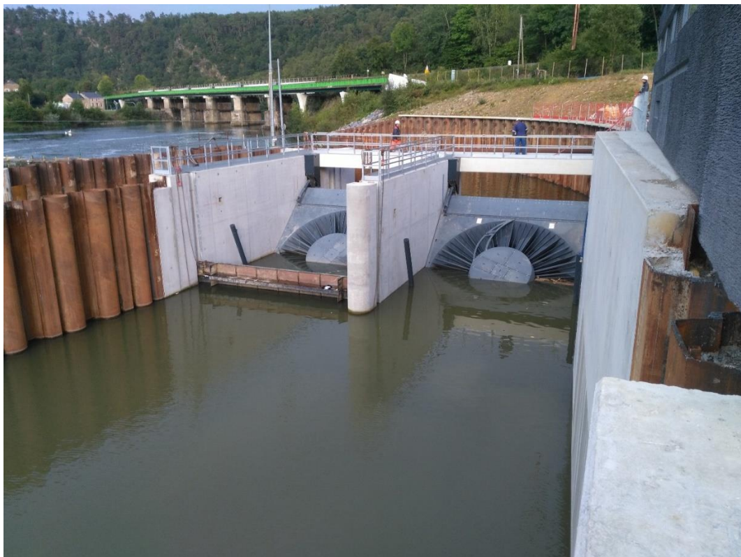
Figure 8 : vue de deux VLH (centrale de Saint Jospeh, 2*25 \text{ m}^3/\text{s} , Franc)
