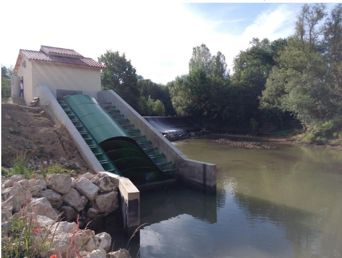
Figure 9 : vue d'une vis hydrodynamique (centrale de Graziac, 7 \text{ m}^3/\text{s} , France)
