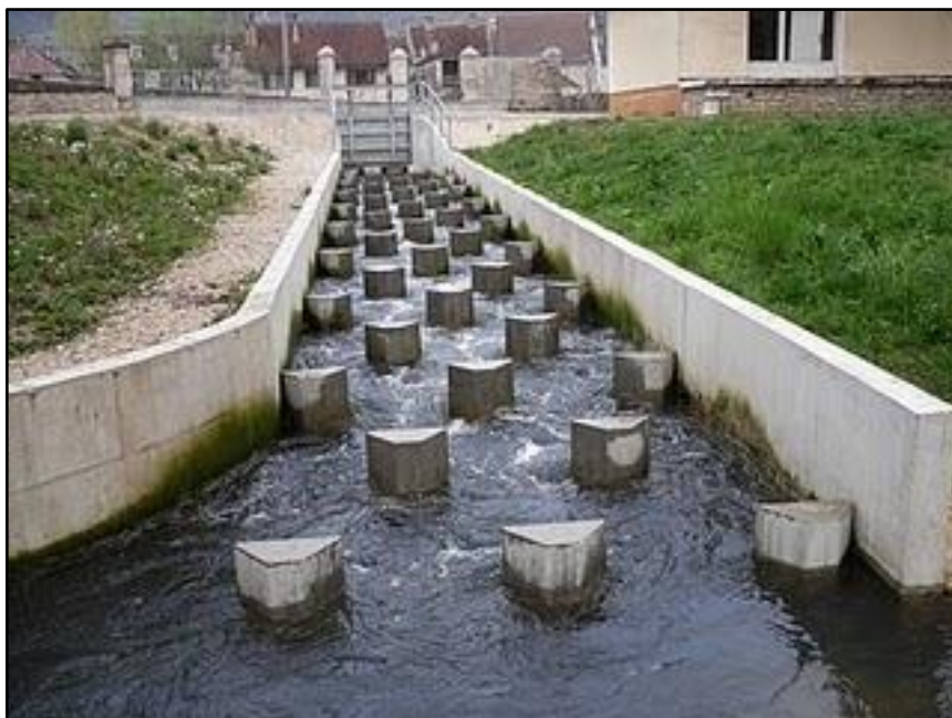
Rampe à macro-rugosités (RMR), blocs béton régulièrement répartis
