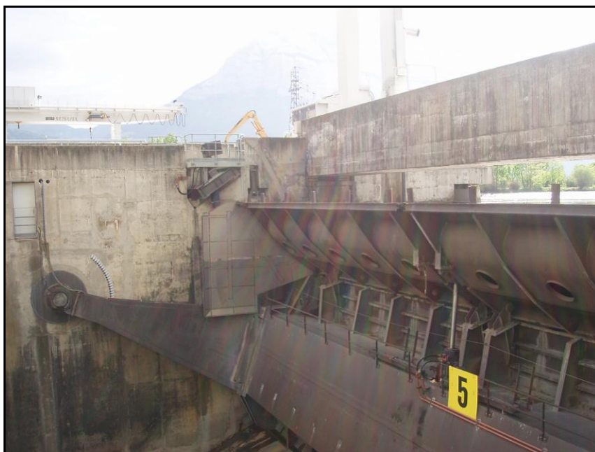
Fig. 33. Exemple du barrage de Saint-Egrève sur l'Isère. Vanne segment à clapet déversant
