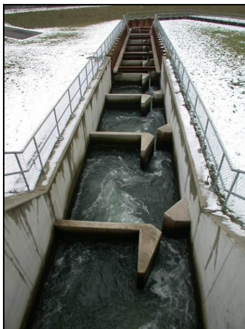
Fig. 44. Passe à une fente verticale
