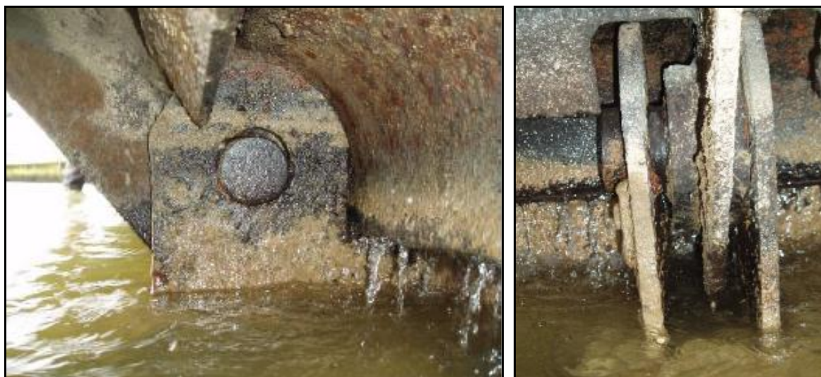
Fig. 14. Photos de paliers courant des clapets du déversoir
