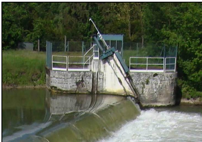
Fig. 10. Culée rive droite du déversoir
