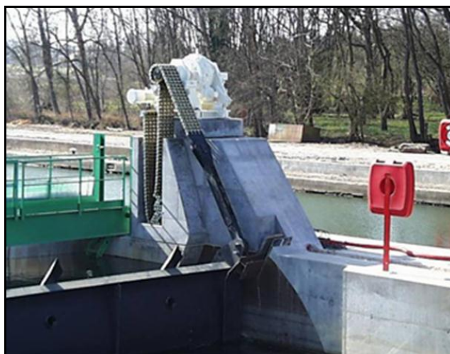
Fig. 37. Exemple de treuils à chaîne
