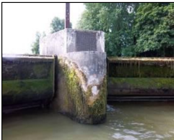
Fig. 12. Pile intermédiaire de la partie déversoir du barrage
