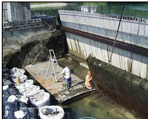
Fig. 39. Exemple de batardeau à aiguilles pour maintenance de clapet – Barrage Joinville
