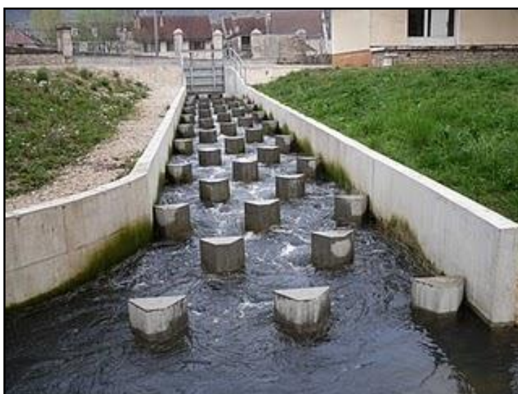
Fig. 45. Rampe à macro-rugosités (RMR), blocs béton régulièrement répartis
