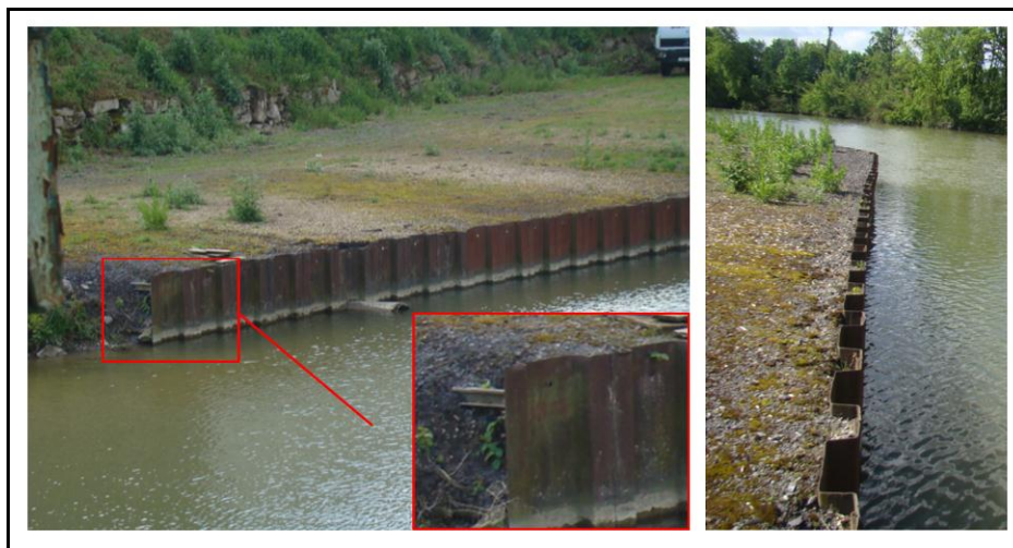
Fig. 47. Quai en palplanches amont rive droite du barrage
