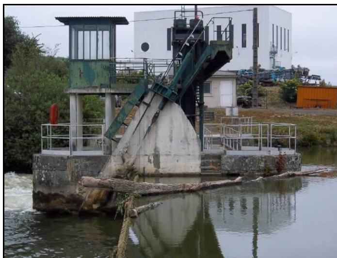
Fig. 11. Pile de séparation « pertuis – déversoir » - vue depuis le déversoir
