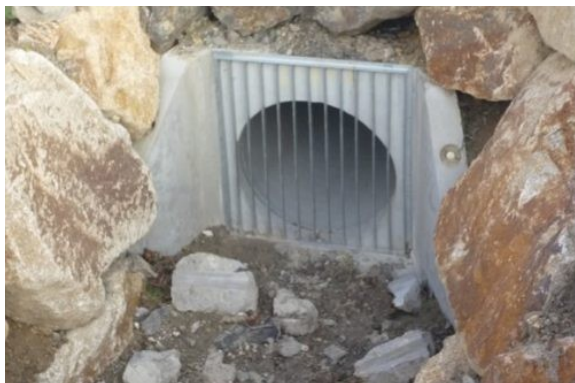
Exemple de tête d'aqueduc (ici un produit préfabriqué)
