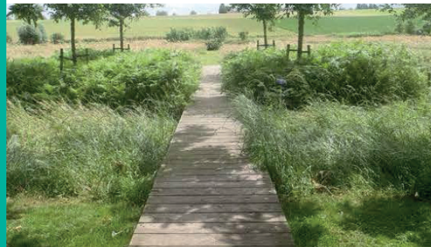
aménager des pontons en bois pour le franchissement des zones humides
