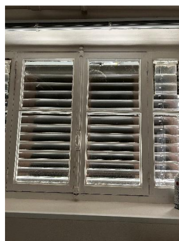
Menuiserie simple vitrage bois avec BSO Bâtiment F
