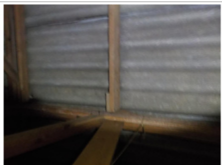
SD - Inspection visuelle 2. : RDC / RDC - Plaque ondulée - EP- (Présence d'amiante)
