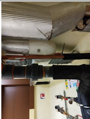
Photo n° PhA088 Localisation : S-Sol R-1 locaux techniques - Couloir accès Grimm Ouvrage : Flocages, Calorifugeages, Faux plafonds Partie d'ouvrage : Calorifugeages Description : Calorifugeages alu (niveau coudes blanc) Localisation sur croquis : M088
