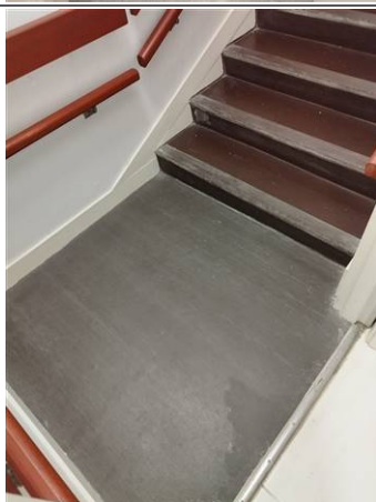
Photo n° PhA062 Localisation : P'tits Polissons RDC - Cage d'escalier Ouvrage : Revêtements de sol (l'analyse doit concerner chacune des couches du revêtement) Partie d'ouvrage : Revêtement plastique avec sous-couche Description : Revêtement plastique avec sous-couche Localisation sur croquis : M062
