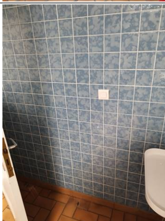
Photo n° PhA060 Localisation : P'tits Polissons RDC - Stockage 1 Ouvrage : Revêtements de murs Partie d'ouvrage : Colles des carrelages Description : Colles des carrelages+Faïence bleue Localisation sur croquis : M060
