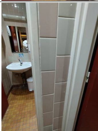
Photo n° PhA028 Localisation : Rez de chaussée Administration - Sanitaires publics Ouvrage : Revêtements de murs Partie d'ouvrage : Faïence grise+colle Description : Faïence grise+colle Localisation sur croquis : M028
