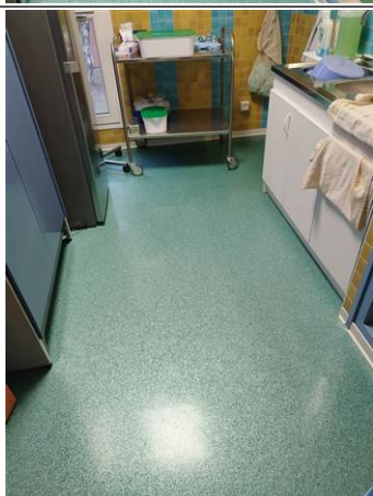
Photo n° PhA036 Localisation : 1er étage La Fontaine - salle désinfection Ouvrage : Revêtements de sol (l'analyse doit concerner chacune des couches du revêtement) Partie d'ouvrage : Vinyle sol vert Description : Revêtement de sol Vinyle Localisation sur croquis : M036
