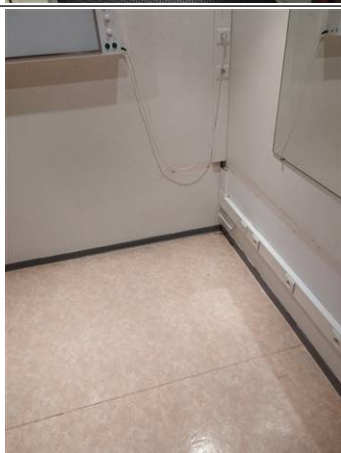
Photo n° PhA004 Localisation : Plateau Technique HC (Rez de chaussée) - Dépôt laboratoire Ouvrage : Revêtements de sol (l'analyse doit concerner chacune des couches du revêtement) Partie d'ouvrage : Revêtement plastique avec sous-couche Description : Revêtement plastique avec sous-couche Localisation sur croquis : M004
