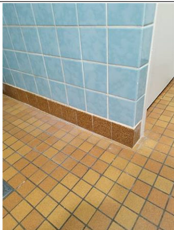
Photo n° PhA067 Localisation : P'tits Polissons RDC - WC personnel Ouvrage : Revêtements de murs Partie d'ouvrage : Colles des carrelages+Plinthes Description : Colles des carrelages+Plinthes Localisation sur croquis : M067
