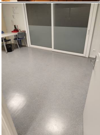
Photo n° PhA061 Localisation : P'tits Polissons RDC - Groupe éducatif Ouvrage : Revêtements de sol (l'analyse doit concerner chacune des couches du revêtement) Partie d'ouvrage : Revêtement plastique avec sous-couche Description : Revêtement plastique avec sous-couche Localisation sur croquis : M061
