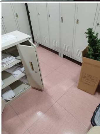
Photo n° PhA013 Localisation : Plateau Technique HC (rez de chaussée) - Vestiaire homme 2 Ouvrage : Revêtements de sol (l'analyse doit concerner chacune des couches du revêtement) Partie d'ouvrage : Dalles plastiques Description : Dalles plastiques (rose) Localisation sur croquis : M013
