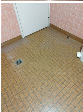
Photo n° PhA005 Localisation : Plateau Technique HC (Rez de chaussée) - WC 1 Ouvrage : Revêtements de sol (l'analyse doit concerner chacune des couches du revêtement) Partie d'ouvrage : Chape maigre Description : Carrelage+colle Localisation sur croquis : M005
