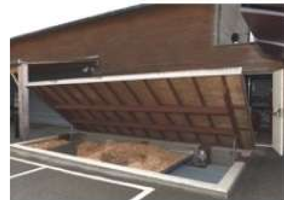
Silo enterré pour plaquettes
