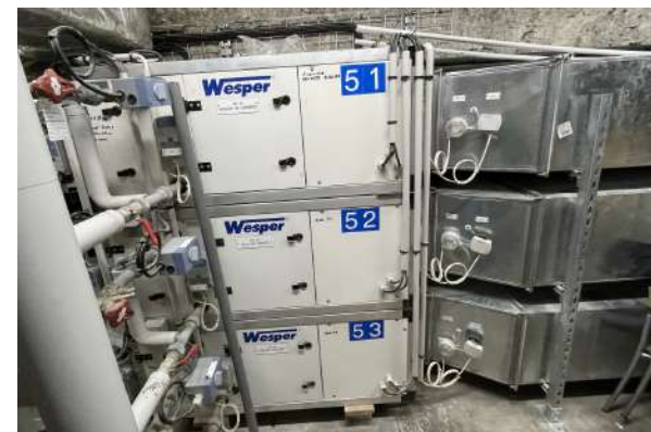
Centrale de traitement d'air
