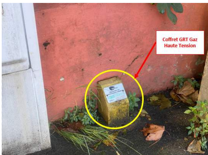
Figure 7 : Illustration du coffret de gaz haute tension
