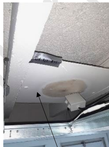
Plaques amiante ciment sur plafond des sanitaires
