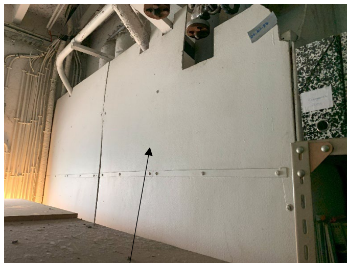
Panneaux en plaques amiante ciment à traiter
