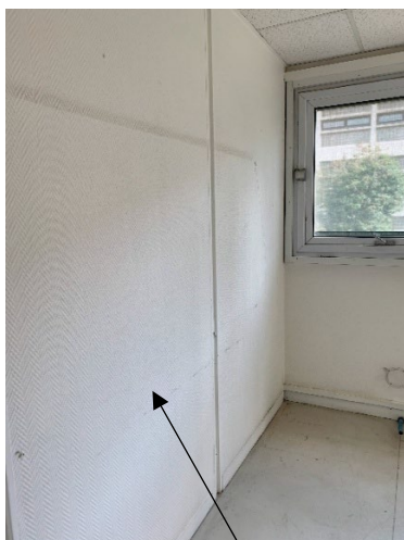
Cloisons en amiante ciment à traiter
