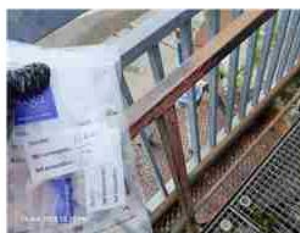
Garde-corps passerelle Métal Peintures noire + rouge 0,15 mg/g - P002
