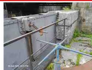
Boîtier fermeture vantelle Peintures grise + jaune + bleue + rouge 2,9 mg / cm²
