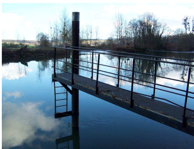
Figure 31 Passerelle sur duc d'albe.
