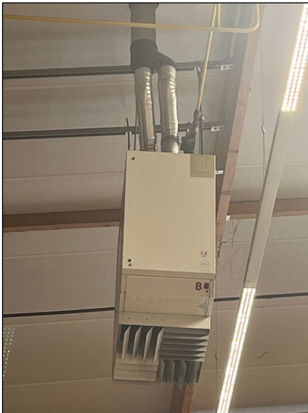
Exemple d'un aérotherme à remplacer
