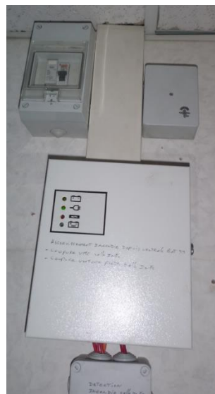
B099 - Centrale détection incendie (Cellule zone désenfumage N°3/ Zone de bureau)
