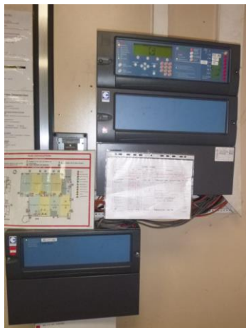
B099 - Centrale détection incendie (Zone Bureau/ 1er niveau)
