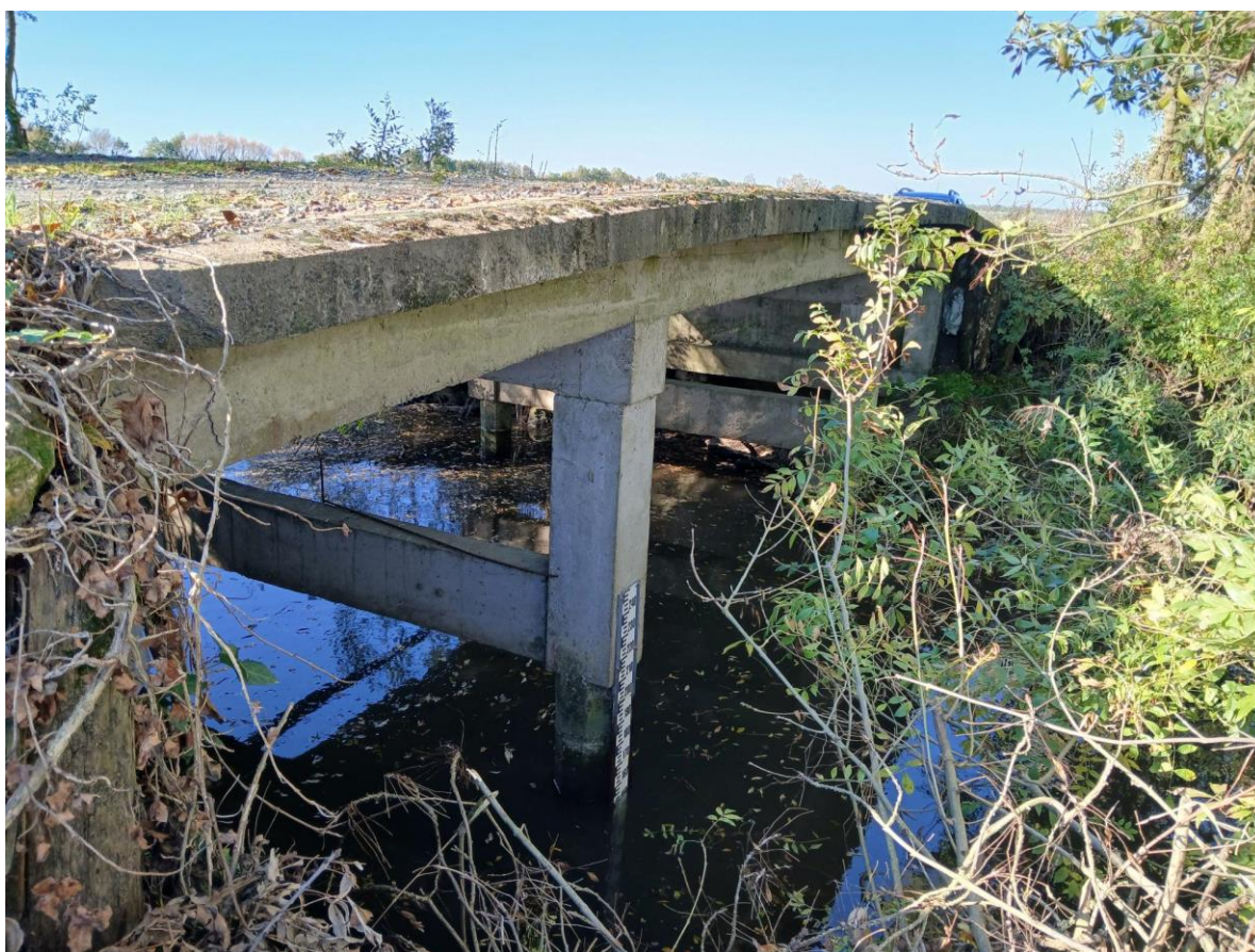
Figure 5 : Photographie de différentes sondes avec des configurations différentes (implantation sur ouvrage ou sur échelle)
