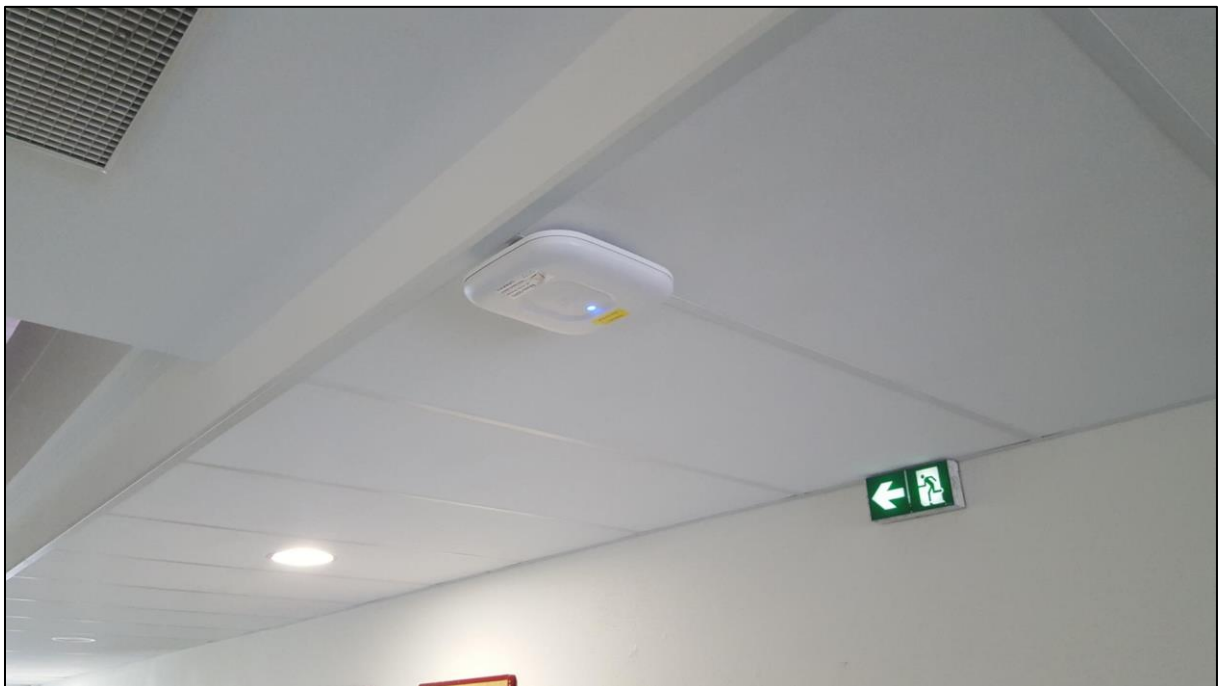
Figure 5 : Exemple de borne posée avec le kit de fixation fourni d'origine sur un faux plafond
