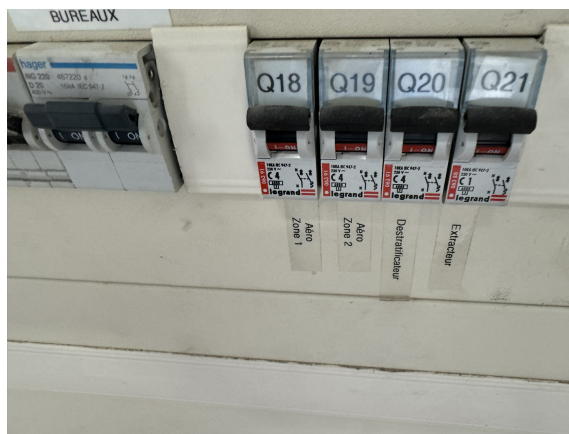
Départ aérothermes gaz et destratificateurs
