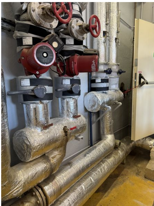
Départ chauffage RDC – R+1-R+2
