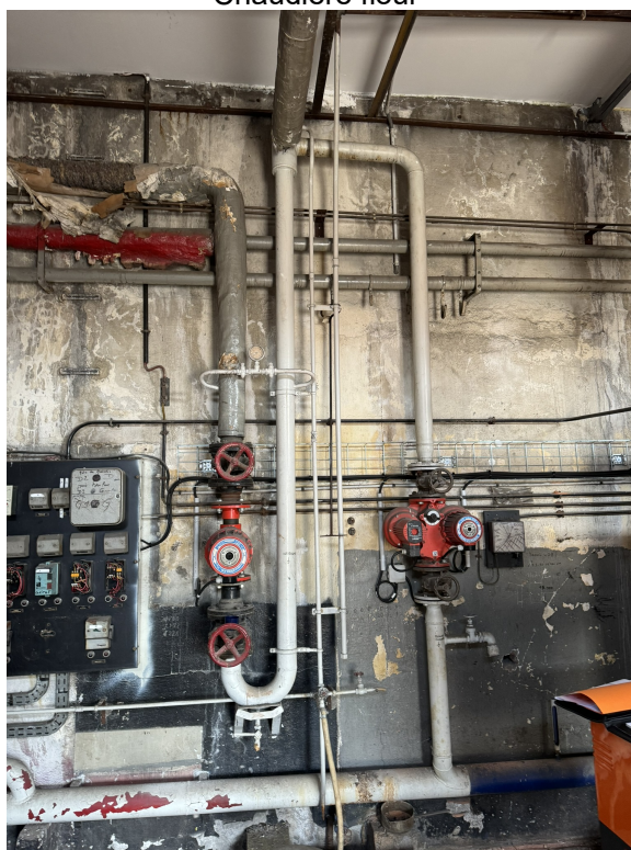
Départ panneaux rayonnant à déposer
