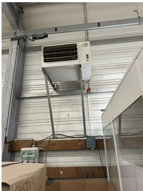
Aérotherme gaz à déposer
