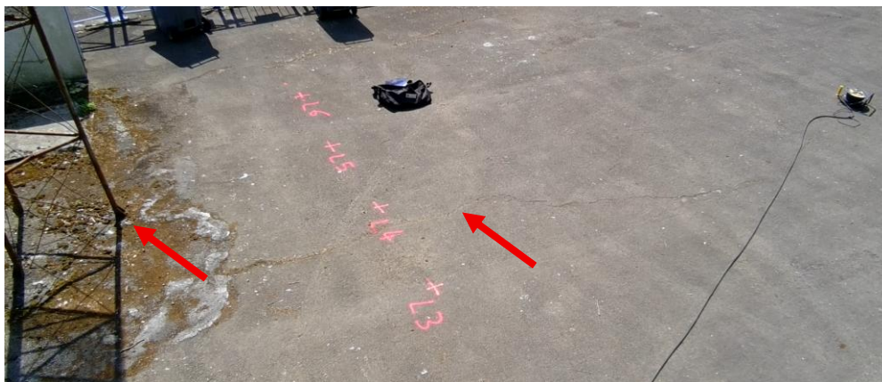
Photo 1 : Vue sur fissures et mousse
