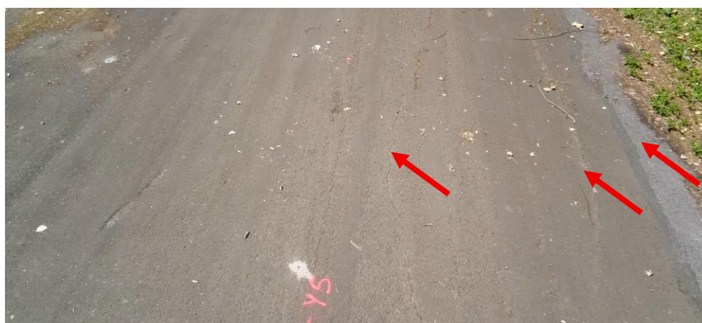
Photo 2 : Vue sur fissures et reprise
