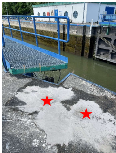
Emplacement carottage C1 et C2
