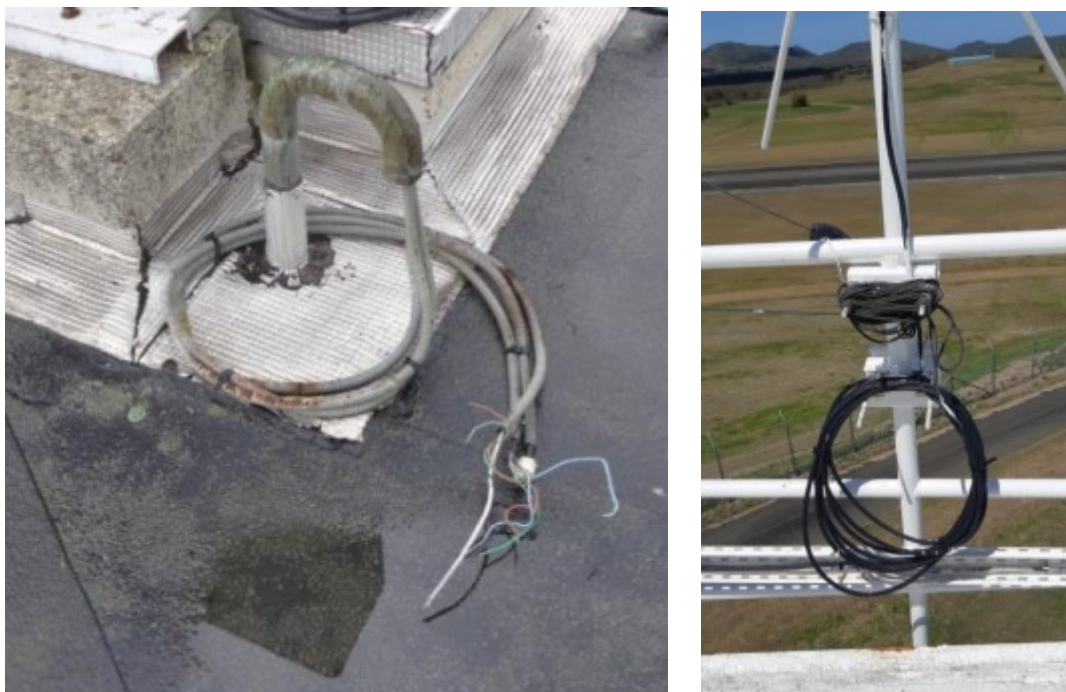
Figure 1 : Exemple de boucle de câbles à proscrire
