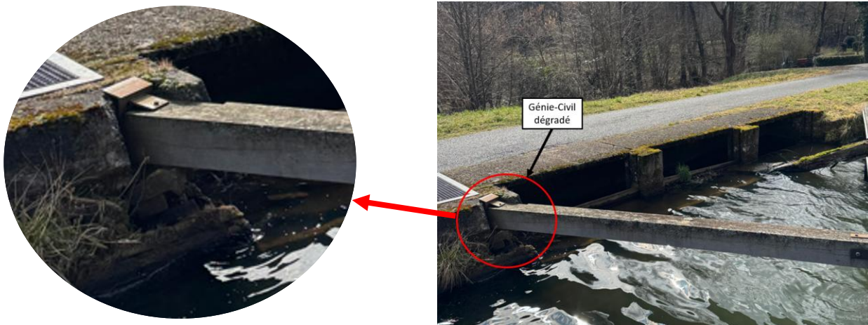
Figure 5 Photo des éléments de Génie-Civil dégradés
