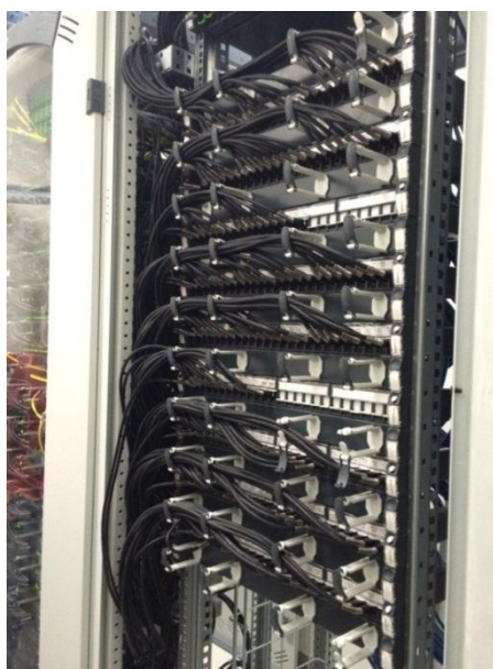
Exemple de câblage de baie passive
