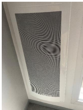
Panneau rayonnant récent Puissance : 2 kW
