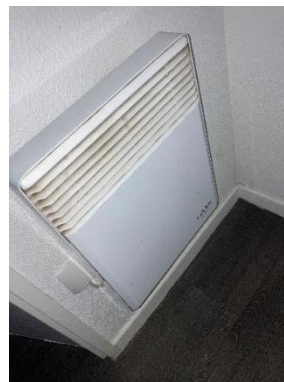
Convecteur électrique peu performant
