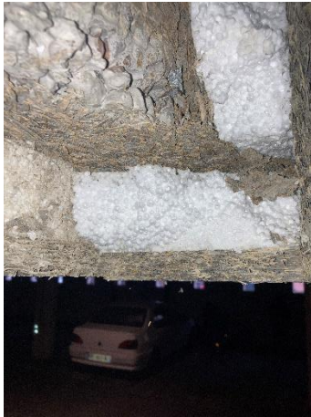
Panneau de fibrastyrène Garages bâtiment B
