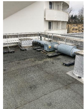
Caisson en toiture terrasse
