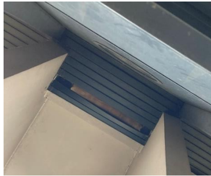
Isolation laine minérale vieillissante Bâtiment A
