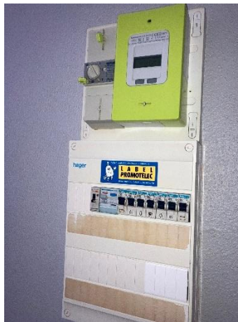
Compteur et tableau électrique dans chaque logement
