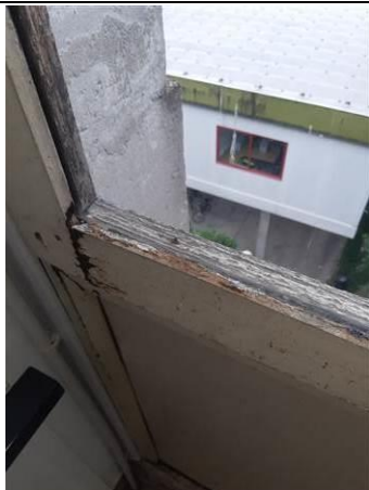
Photo n°_A001 Localisation : STENDHAL / R+3 - Aile D - Escalier Ouvrage : 2 - Parois verticales extérieures et Façades - Menuiseries extérieures Partie d'ouvrage : Joint de mastic de vitrage Description : Joint de mastic de vitrage
