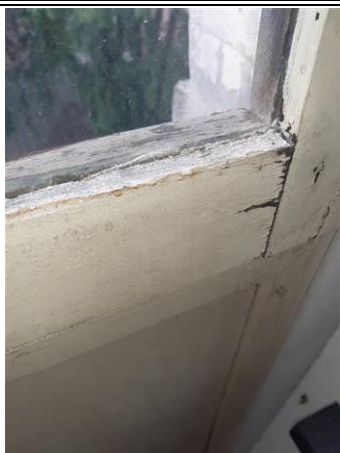
Photo n°_A003 Localisation : STENDHAL / R+1 - Aile D - Escalier Ouvrage : 2 - Parois verticales extérieures et Façades - Menuiseries extérieures Partie d'ouvrage : Joint de mastic de vitrage Description : Joint de mastic de vitrage
