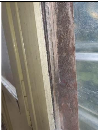
Photo n°_A011 Localisation : STENDHAL / R+2 - Aile A - Escalier Ouvrage : 2 - Parois verticales extérieures et Façades - Menuiseries extérieures Partie d'ouvrage : Joint de mastic de vitrage Description : Joint de mastic de vitrage
