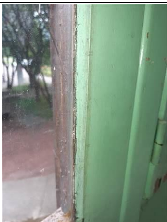
Photo n°_A007 Localisation : STENDHAL / RDC - Aile C - Escalier Ouvrage : 2 - Parois verticales extérieures et Façades - Menuiseries extérieures Partie d'ouvrage : Joint de mastic de vitrage Description : Joint de mastic de vitrage
