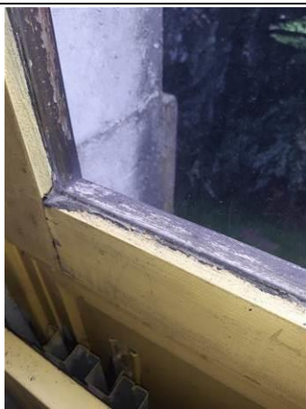
Photo n°_A009 Localisation : STENDHAL / R+2 - Aile B - Escalier Ouvrage : 2 - Parois verticales extérieures et Façades - Menuiseries extérieures Partie d'ouvrage : Joint de mastic de vitrage Description : Joint de mastic de vitrage
