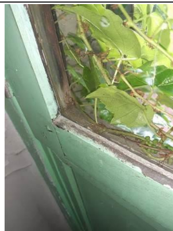
Photo n°_A006 Localisation : STENDHAL / R+1 - Aile C - Escalier Ouvrage : 2 - Parois verticales extérieures et Façades - Menuiseries extérieures Partie d'ouvrage : Joint de mastic de vitrage Description : Joint de mastic de vitrage
