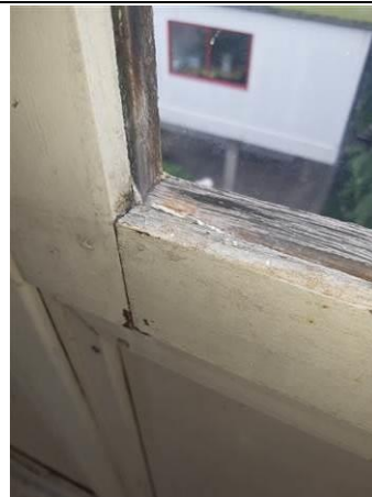
Photo n°_A002 Localisation : STENDHAL / R+2 - Aile D - Escalier Ouvrage : 2 - Parois verticales extérieures et Façades - Menuiseries extérieures Partie d'ouvrage : Joint de mastic de vitrage Description : Joint de mastic de vitrage
