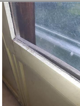
Photo n°_A012 Localisation : STENDHAL / R+1 - Aile A - Escalier Ouvrage : 2 - Parois verticales extérieures et Façades - Menuiseries extérieures Partie d'ouvrage : Joint de mastic de vitrage Description : Joint de mastic de vitrage
