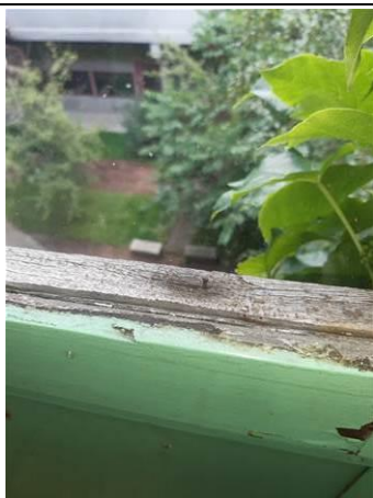
Photo n°_A005 Localisation : STENDHAL / R+2 - Aile C - Escalier Ouvrage : 2 - Parois verticales extérieures et Façades - Menuiseries extérieures Partie d'ouvrage : Joint de mastic de vitrage Description : Joint de mastic de vitrage
