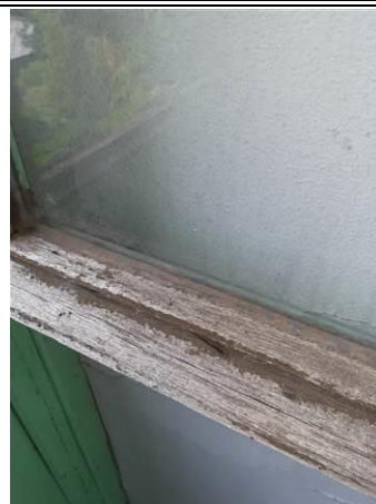
Photo n°_A004 Localisation : STENDHAL / R+3 - Aile C - Escalier Ouvrage : 2 - Parois verticales extérieures et Façades - Menuiseries extérieures Partie d'ouvrage : Joint de mastic de vitrage Description : Joint de mastic de vitrage
