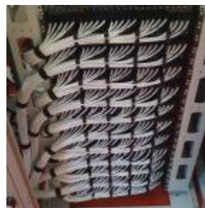
Exemples de raccordements sur panneaux de brassage
