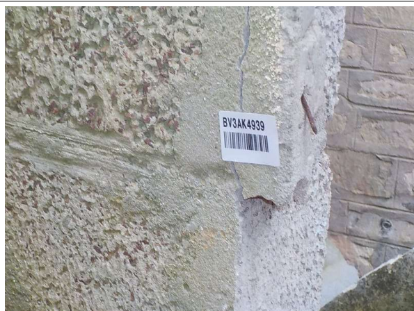
Prélèvement - P1 : Cabanon - Enduit- (Absence d'amiante)
