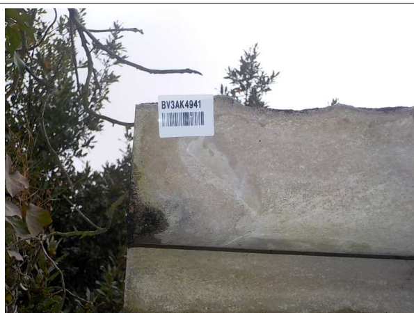
Prélèvement - P3 : Cabanon - Plaque ondulée- (Présence d'amiante)
