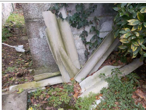
prélevé - idem P3 : Extérieur - Plaque ondulée- (Présence d'amiante)
