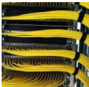
Exemples de raccordements sur panneaux de brassage
