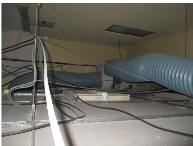
Doc ST III-4 : Groupe d'extraction et gaines souples de la hotte laminaire 070
