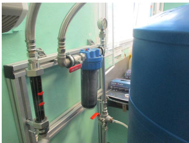
Doc DG-5 - Filtration des eaux de rinçage
