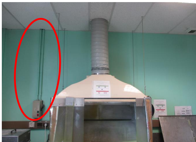
Doc ST IV-5 : Commande électrique du groupe de ventilation
