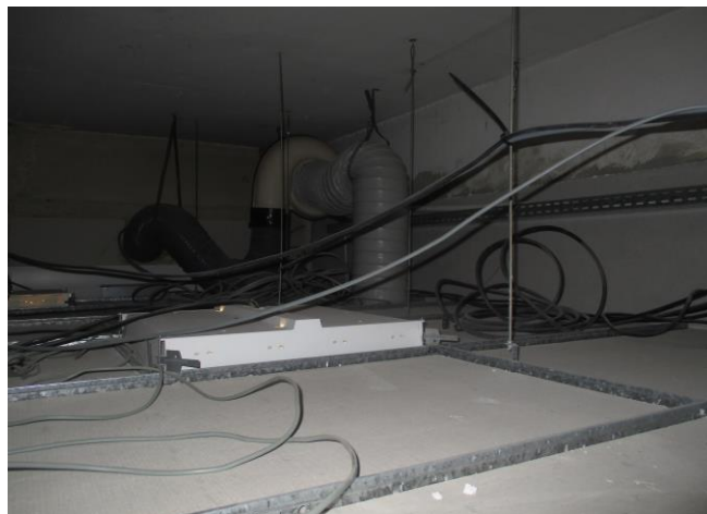
Doc ST III-7 - Groupe d'extraction et gaines souples du bac de lavage sous UV
