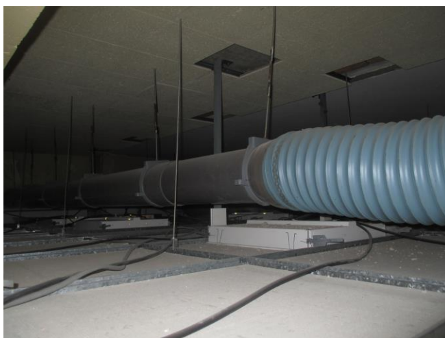
Doc ST III-5 : Gainex souples et gaines rigides de la hotte laminaire 070
