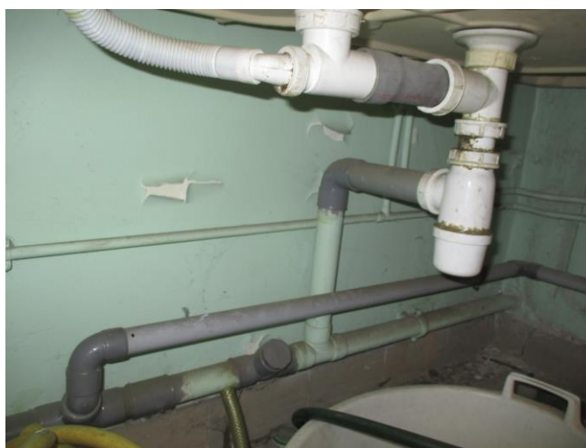
Doc DG-2 - Réseau intérieur d'évacuation EU - Evier 055 et condensats 070
