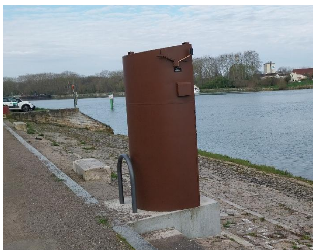
Figure 3 : Borne eau/électricité
