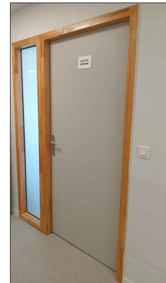
4 Portes bureaux + châssis fixe
