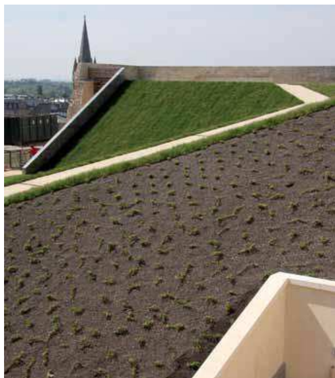
Utilisation de Sopranature sur des pentes de plus de 60 % grâce à des supports de retenue du substrat.
