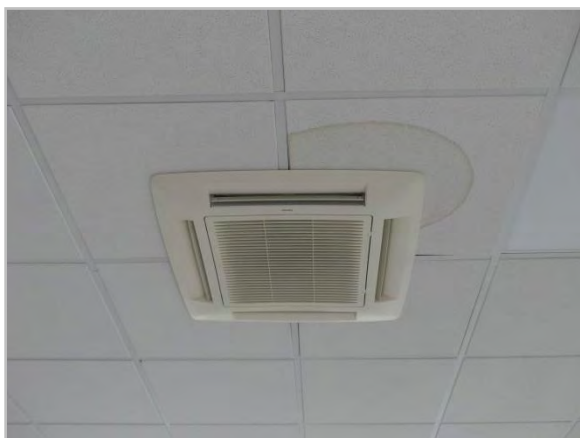
Figure 17 : Trace d'infiltration autour d'une cassette.
