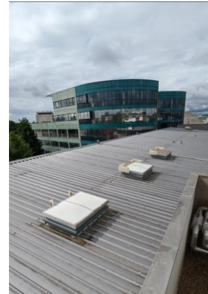
Bac acier Aile C et Façade Nord Aile B
