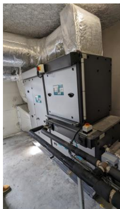
Flocage thermique dans local CTA Aile A RDC
