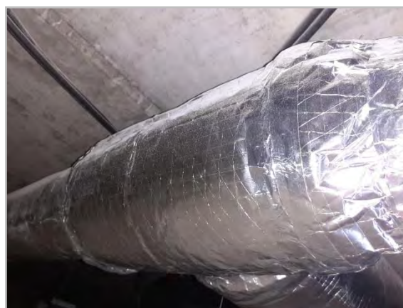
Figure 25 : Isolation des conduites en bon état.
