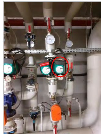
Figure 23 : Défaut pompe de circulaire.
