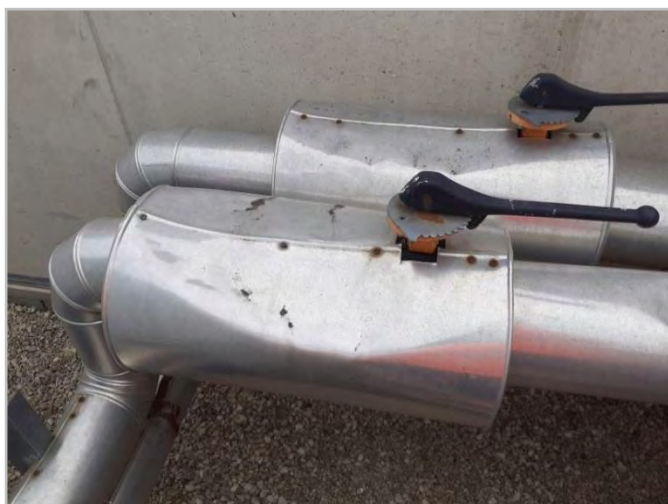
Figure 19 : Légère déformation sur la conduite en aluminium.
