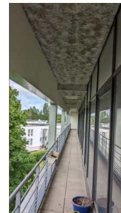
Flocage thermique terrasse R+2 Aile B
