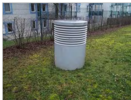
Figure 27: Photo puits canadien
