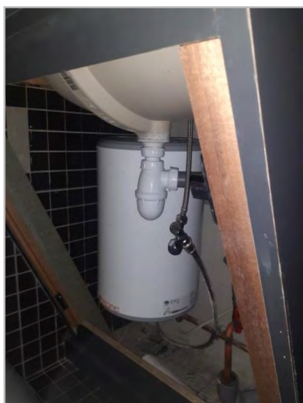
Figure 21 : Absence de dispositif anti-retour.
