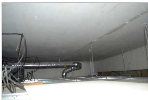
Figure 11 : Absence d'isolation entre le faux plafond et la dalle des planchers.
