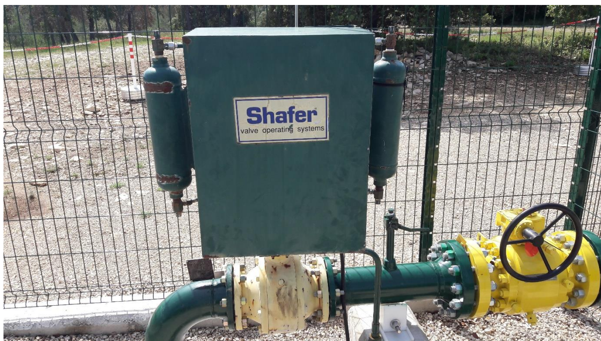
Photo 1 : Electrovanne à proximité du poste de détente de GRT gaz
