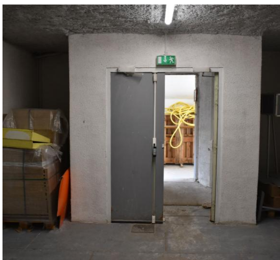
Vue intérieure de la porte de l'issue de secours du rez-de-jardin depuis le dégagement droite. Le sas et une rampe ont été aménagés.
