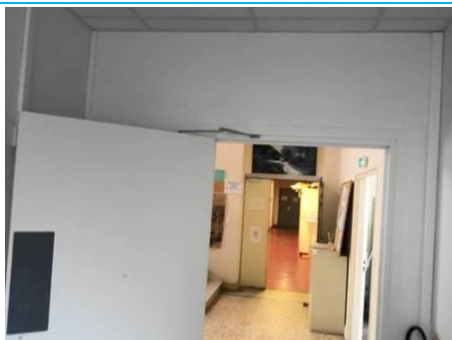
Matériaux : ZPSO-072 Prélèvement : P074 Description : Enduit à base de plâtre lissé sur mur Localisation : Rez de chaussée - Circulation 5 Résultat : Absence d'amiante
