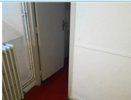
Matériaux : ZPSO-031 Prélèvement : P031 Description : Enduit à base de plâtre lissé sur cloison Localisation : Sous-Sol - Sanit H Résultat : Absence d'amiante
