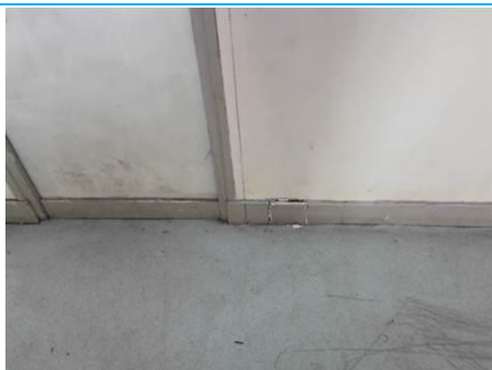
Matériaux : ZPSO-109 Prélèvement : P128 Description : Colle de plinthes carrelage Localisation : 3ème étage - Salle de dessin 3 Résultat : Absence d'amiante
