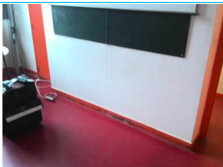
Matériaux : ZPSO-063 Prélèvement : P064 Description : Enduit à base de plâtre lissé sur cloison Localisation : Rez de chaussée - salle de classe Résultat : Absence d'amiante
