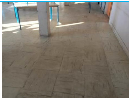
Matériaux : ZPSO-084 Prélèvement : P087 Description : Colle de dalle de sol souples + ragréage Localisation : 2ème étage - Réfectoire Résultat : Absence d'amiante
