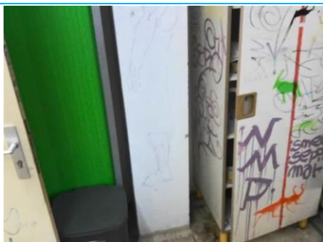
Matériaux : ZPSO-016 Prélèvement : P016 Description : Enduit à base de plâtre lissé sur poteaux Localisation : Sous-Sol - Cuisine Résultat : Absence d'amiante
