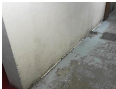
Matériaux : ZPSO-025 Prélèvement : P025 Description : Enduit à base de plâtre lissé au mur Localisation : Sous-Sol - Circulation 2 Résultat : Absence d'amiante
