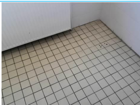
Matériaux : ZPSO-080 Prélèvement : P082 Description : Colle de carrelage Localisation : 2ème étage - Sanitaires H Résultat : Absence d'amiante
