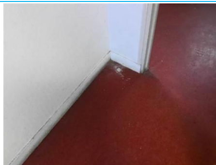
Matériaux : ZPSO-027 Prélèvement : P027 Description : Revêtement souple + colle + ragréage Localisation : Sous-Sol - Sanit H Résultat : Absence d'amiante
