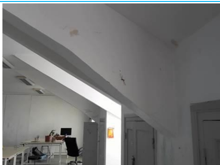
Matériaux : ZPSO-111 Prélèvement : P130 Description : Enduit à base de plâtre lissé sur poutre au plafond Localisation : 3ème étage - Salle de dessin 3 Résultat : Absence d'amiante
