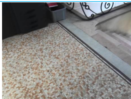
Matériaux : ZPSO-042 Prélèvement : P065 Description : Colle de carrelage Localisation : Rez de chaussée au 3ème étage - Cage d'escalier 2 Résultat : Absence d'amiante
