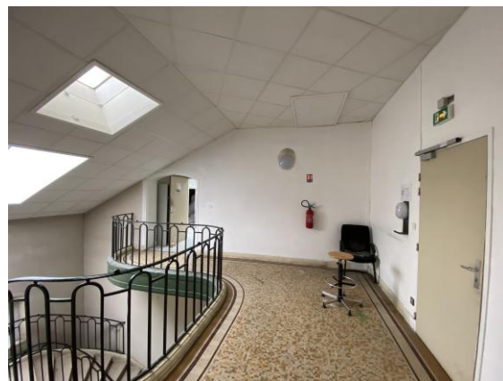
Les portes PF1/2h donnant directement sur la circulation verticale encloisonnée, deuxième étage.
