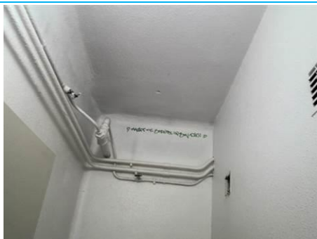
Matériaux : ZPSO-026 Prélèvement : P026 Description : Enduit à base de plâtre lissé au plafond Localisation : Sous-Sol - WC H Résultat : Absence d'amiante
