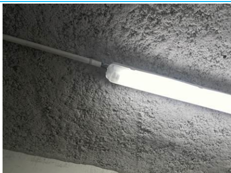
Matériaux : ZPSO-014 Prélèvement : P014 Description : Flocage au plafond Localisation : Sous-Sol - Cuisine Résultat : Absence d'amiante
