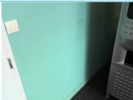
Matériaux : ZPSO-069 Prélèvement : P071 Description : Enduit à base de plâtre lissé sur mur Localisation : Rez de chaussée - Circulation 4 Résultat : Absence d'amiante
