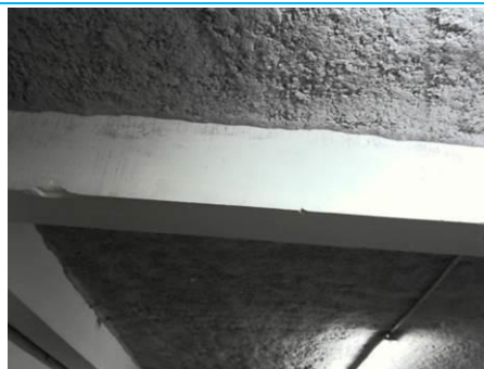
Matériaux : ZPSO-015 Prélèvement : P015 Description : Enduit à base de plâtre lissé sur poutre au plafond Localisation : Sous-Sol - Cuisine Résultat : Absence d'amiante
