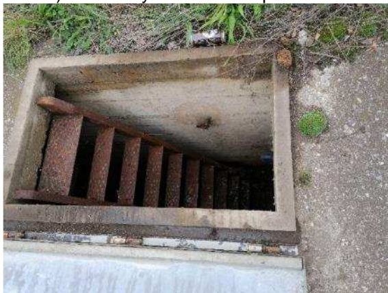
Photographie 11 : cuve ne présentant que quelques boues (fosse 1)
