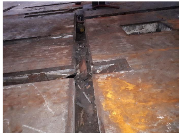
Figure 5 : Fosses et caniveaux du bâtiment F, remplis de liquides huileux et autres matériaux souillés
