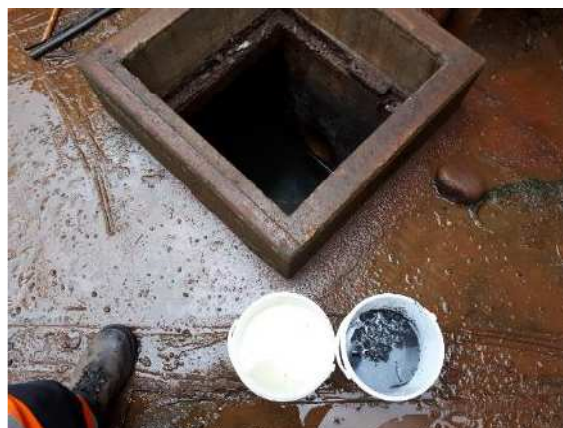
Photographie 14 : Fosse contenant des eaux claires et des sédiments (fosse 2Fc)
