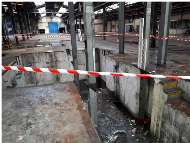
Figure 5 : Fosses et caniveaux du bâtiment F, remplis de liquides huileux et autres matériaux souillés
