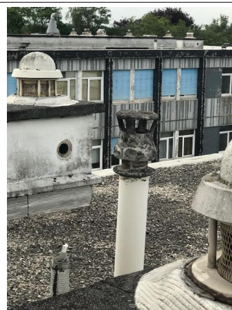
Déclaré - : BATIMENT SN4 / EXTERIEUR / TOUS NIVEAUX / FACADES ET TOITURE - Accessoire de couverture - EP- (Présence d'amiante)
