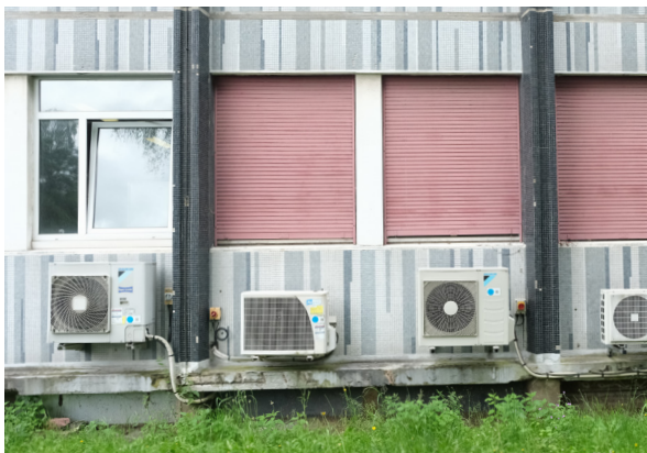
Plusieurs ventilation ext. ont été rajouté à la façade pour assurer la ventilation de certains dispositifs techniques.
