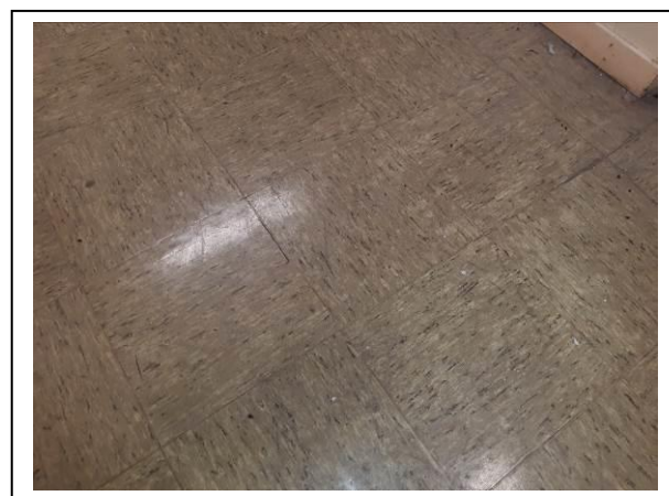
3 ème étage Photo du revêtement de sol jaunâtre
