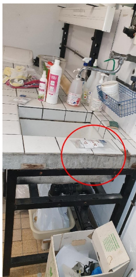
1 - Colle de carrelage - USTL - SN4 - Salle 11 bis - Paillasse : AMIANTE DETECTE
