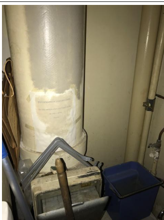
Déclaré - : BATIMENT SN4 / INTERIEUR / 2 ETAGE / 201 ENTRETIEN - Conduit - EP- (Présence d'amiante)
