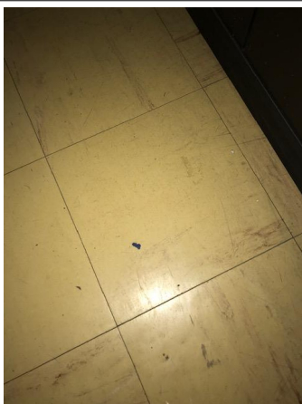
Déclaré - : BATIMENT SN4 / INTERIEUR / RDC / 006 BUREAU - Dalle de sol - AC1- (Présence d'amiante)
