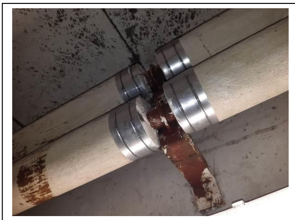
Sous-sol Photo des embouts de calorifuges
