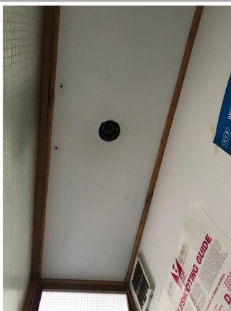
Déclaré - : BATIMENT SN4 / INTERIEUR / 1 ETAGE / 115 BUREAU - Plaque - EP- (Présence d'amiante)
