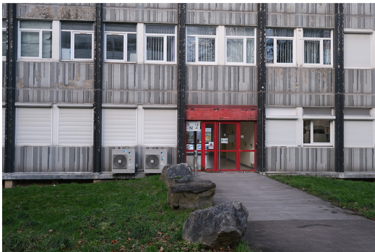
SN2: Composition façade avec fenêtres de la deuxième génération et portes originales
