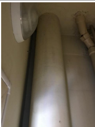
Déclaré - : BATIMENT SN4 / INTERIEUR / 1 ETAGE / LOCAL ENTRETIEN - Conduit - EP- (Présence d'amiante)
