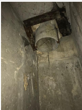
Déclaré - : BATIMENT SN4 / INTERIEUR / SOUS SOL / 1 RESERVE - Conduit - EP- (Présence d'amiante)
