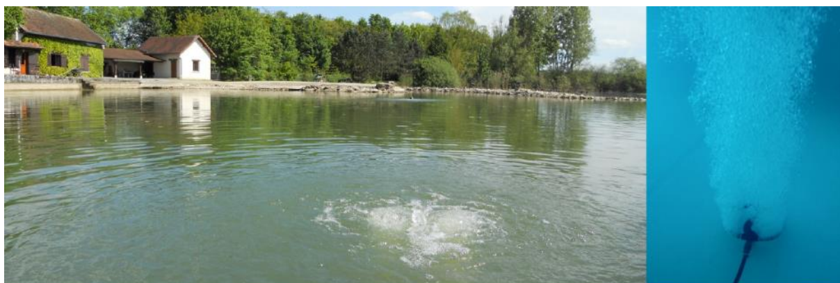
Figure 11 : Diffuseur ZEFAIR® en fonctionnement. Crédit Inoval
