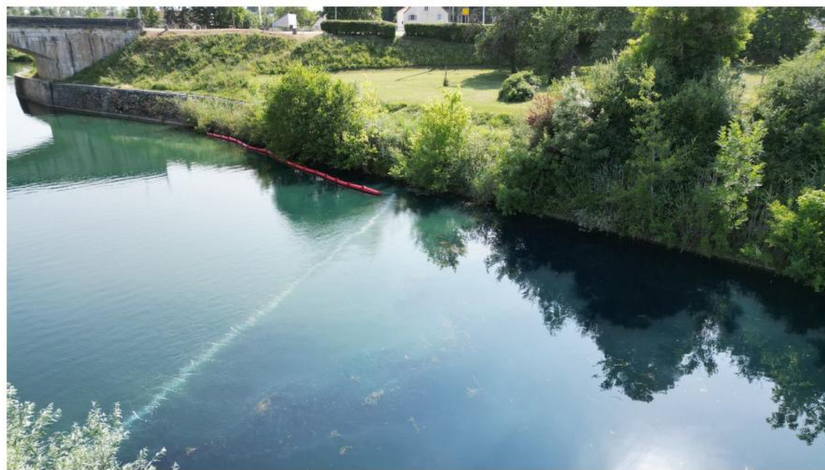
RIDEAU DE BULLE INSTALLÉ EN 2023. ON OBSERVE UN BARRAGE FLOTTANT À SON EXTRÉMITÉ AFIN DE TESTER UN RAMASSAGE DEPUIS LA BERGE.
