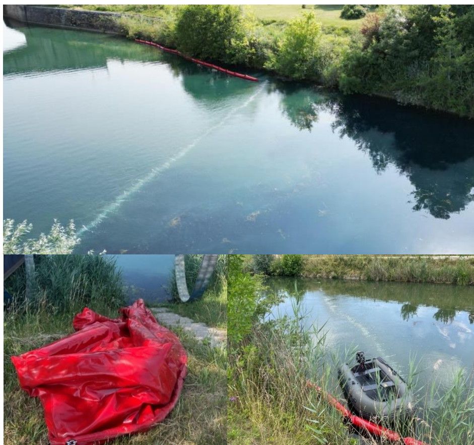
Figure 10 : vue aérienne du rideau à bulles et du barrage flottant. Crédit Inoval
