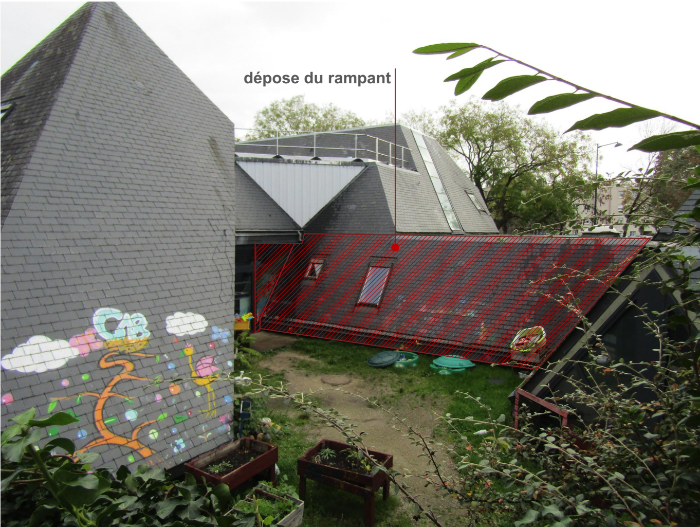
B- rampant à déposer
