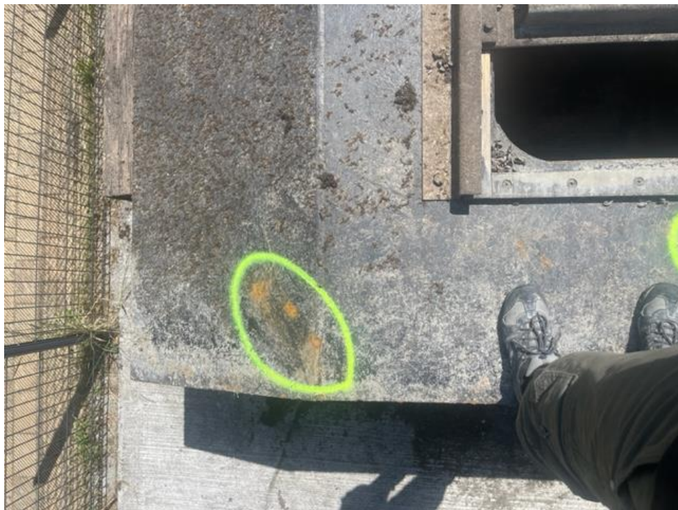
Présence de corrosions sur la partie basse du bordée, Vue d'une butée basse de brimbale rajoutée.
