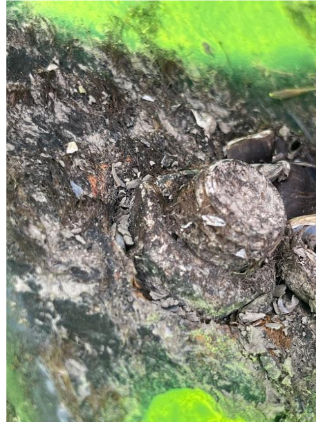
Présence de corrosions au niveau des arêtes et mauvaises fixations de la butée
