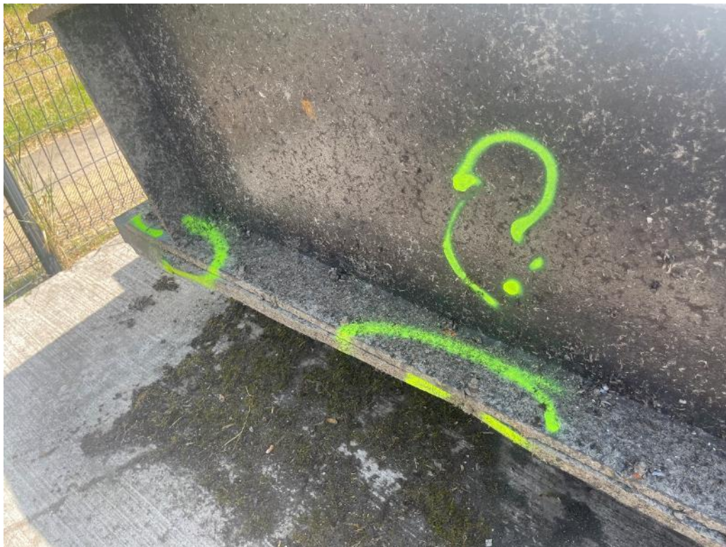
Déformation avec mauvaises fixations et présence de corrosions au niveau des arêtes
