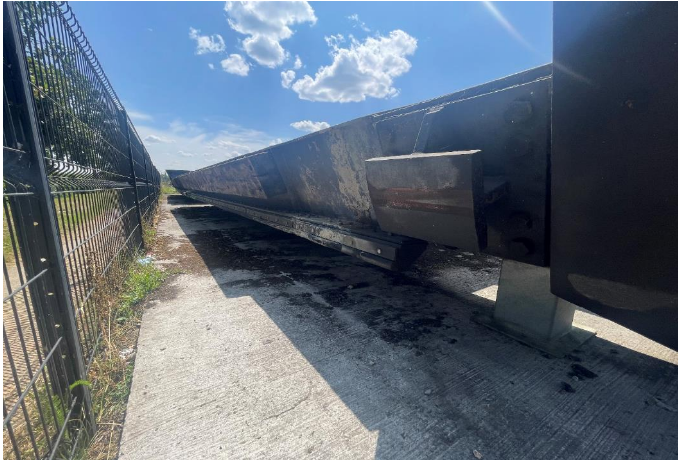
Traces de corrosions sur heurtoir
