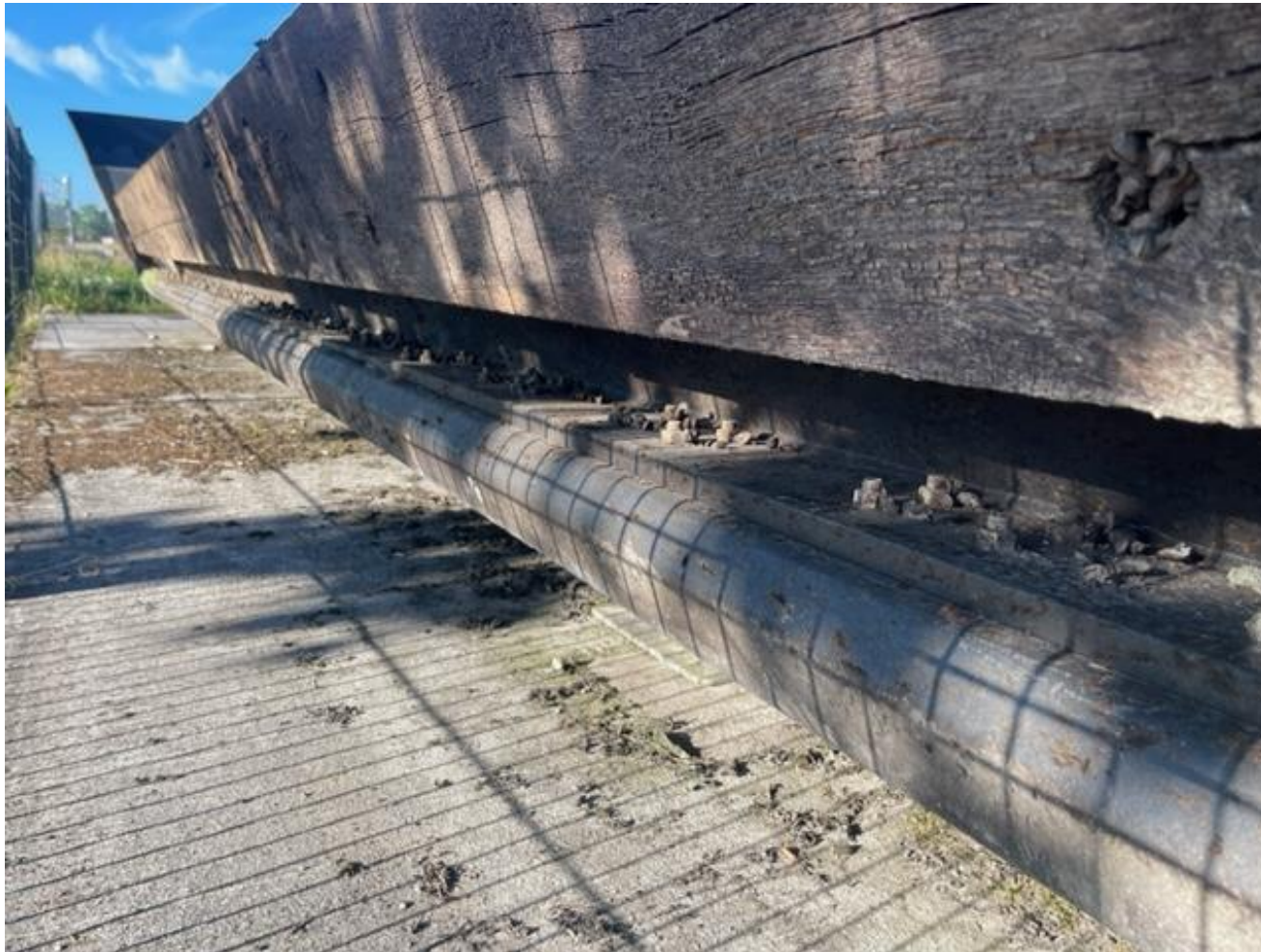
Vue de la contre butée de joint
