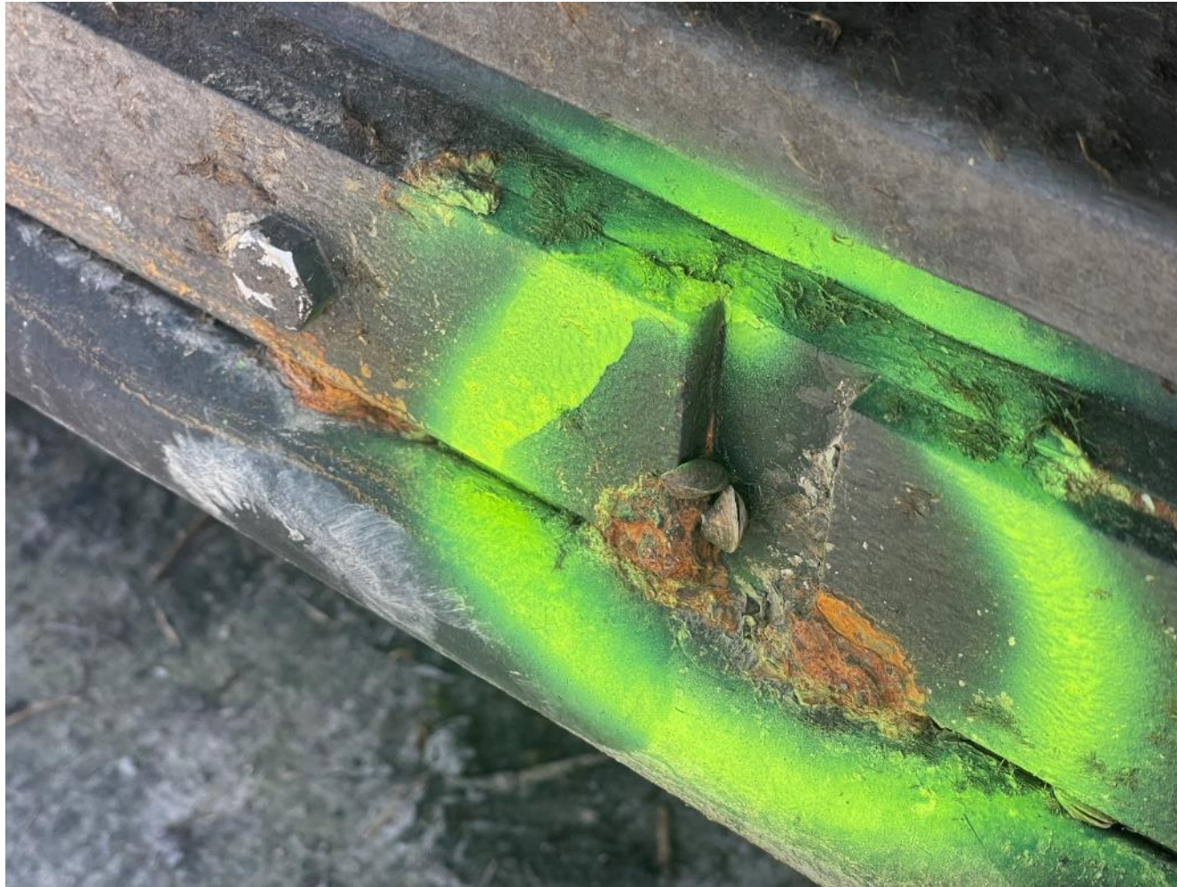
Trace de corrosion sur d'anciennes soudures non protégés
