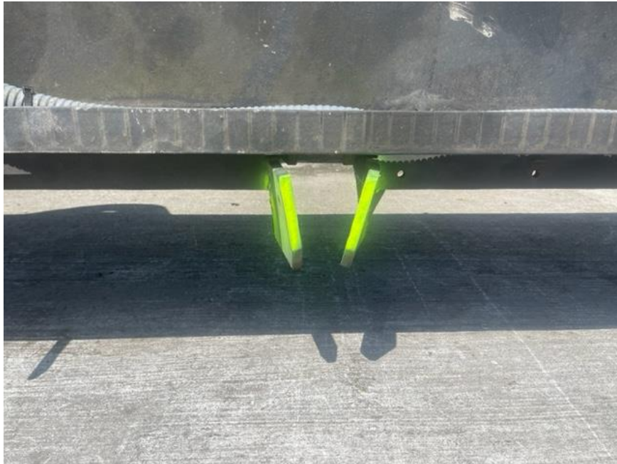
Ancien support de vérin de clapet, structure en déformation.
