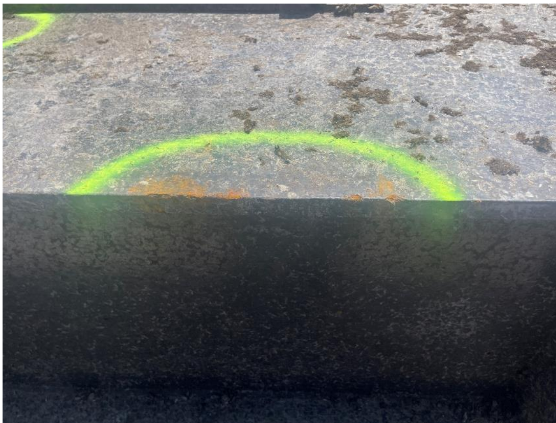
Présence de corrosions au niveau des arêtes
