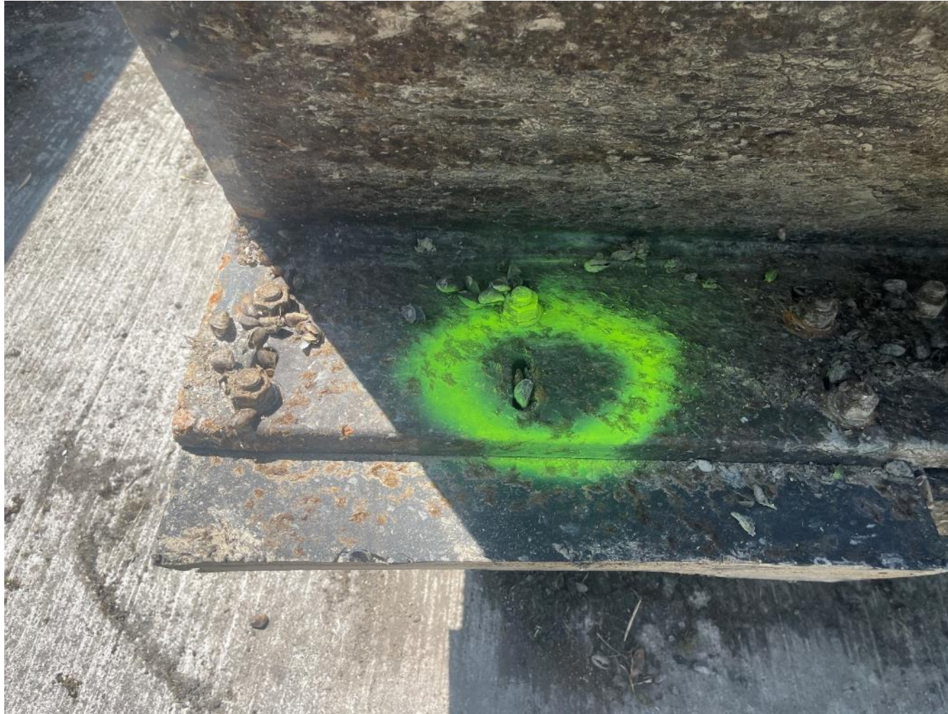
Manque visserie, traces de corrosions
