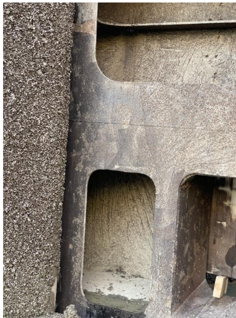
Vue des frottements tôles de vantelles
