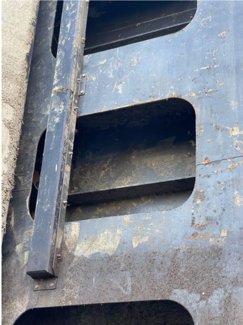
Présence d'impacts et de corrosions
