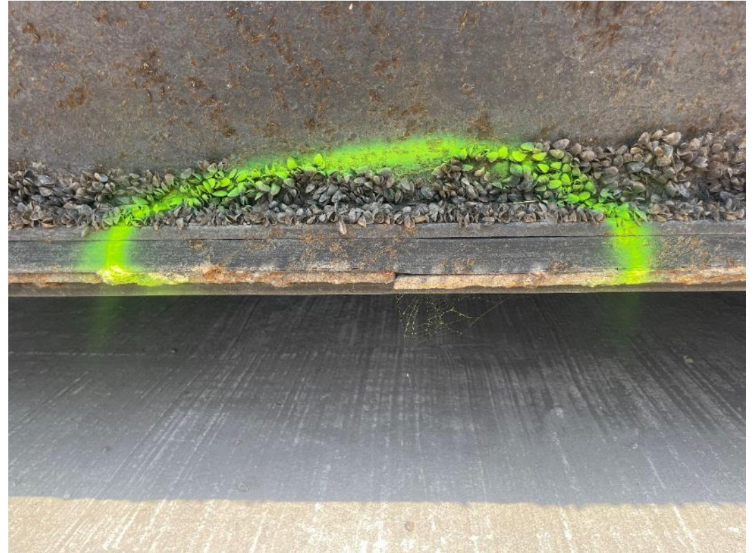
Trace de corrosion
