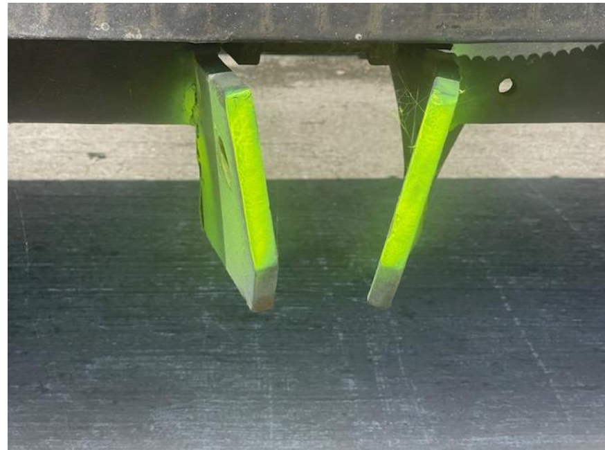
Ancien support de vérin de clapet, structure en déformation.
