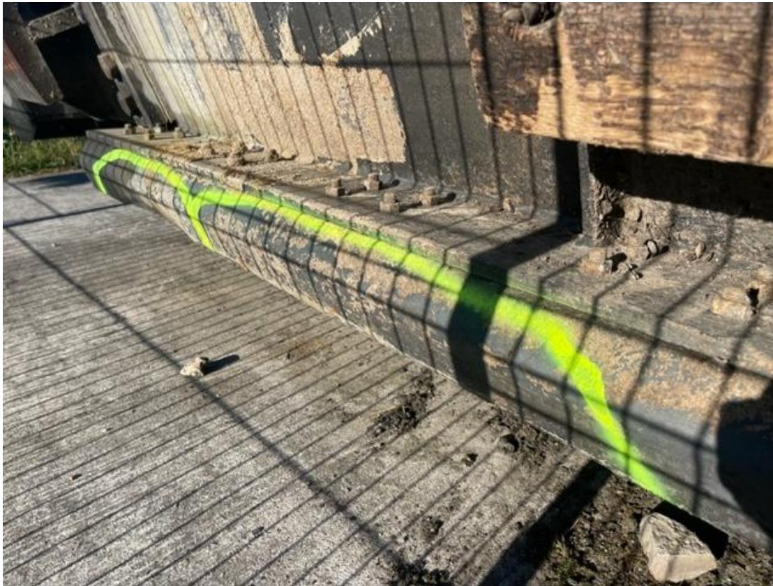
Déformation de la contre-butée au niveau haut du vantail.
