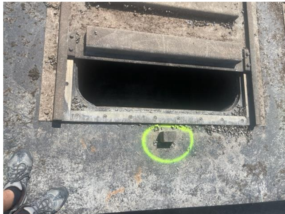
Présence de corrosions sur la partie basse du bordée, Vue d'une butée basse de brimbale rajoutée.
