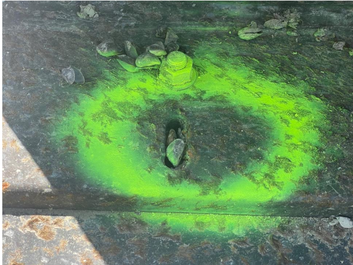
Manque visserie, trace de corrosions
