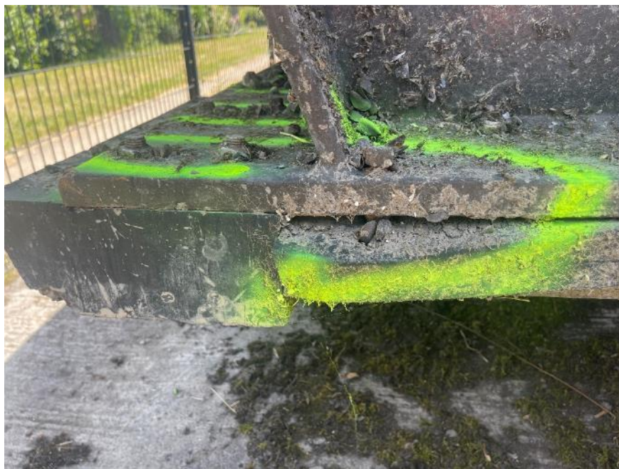
Présence de corrosions au niveau des arêtes et mauvaises fixations de la butée
