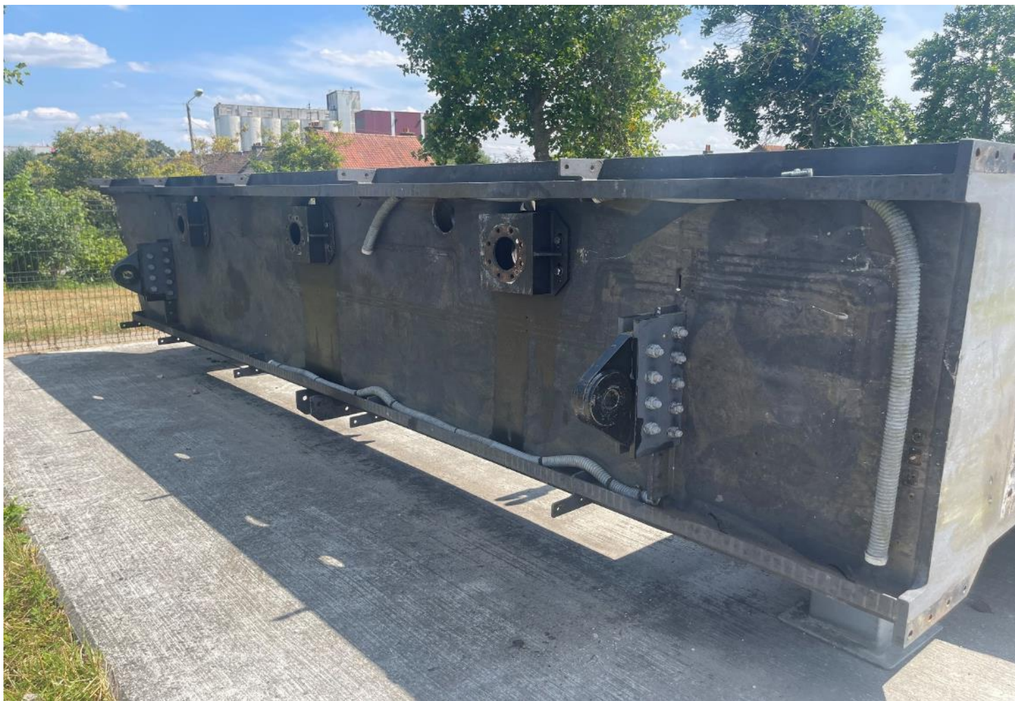
Plans de pose vérins corrodés.
