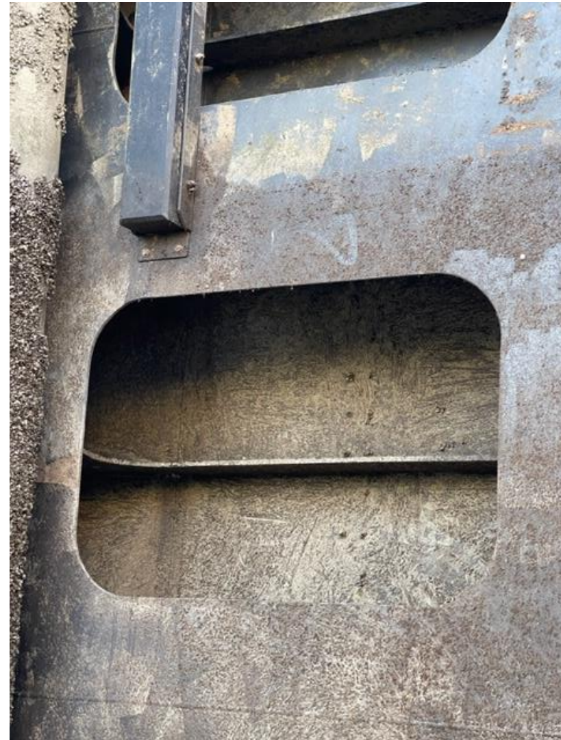
Présence d'impacts et de corrosions
