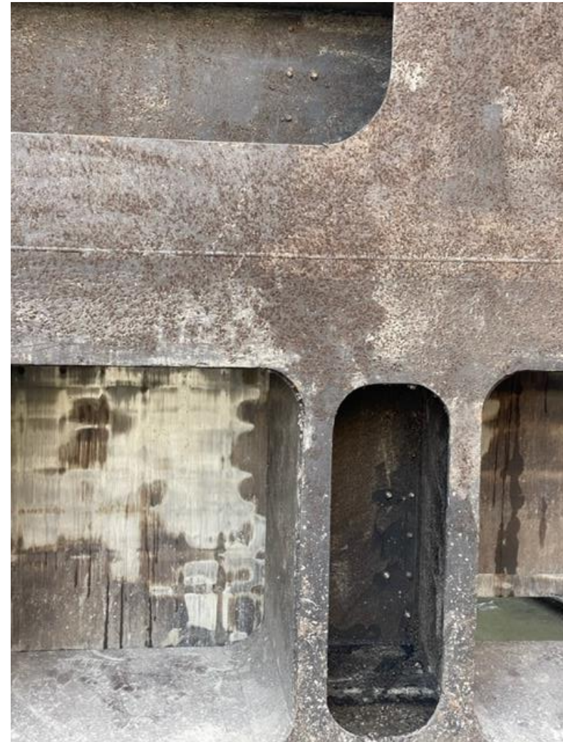
Vue des frottements tôles de vantelles
