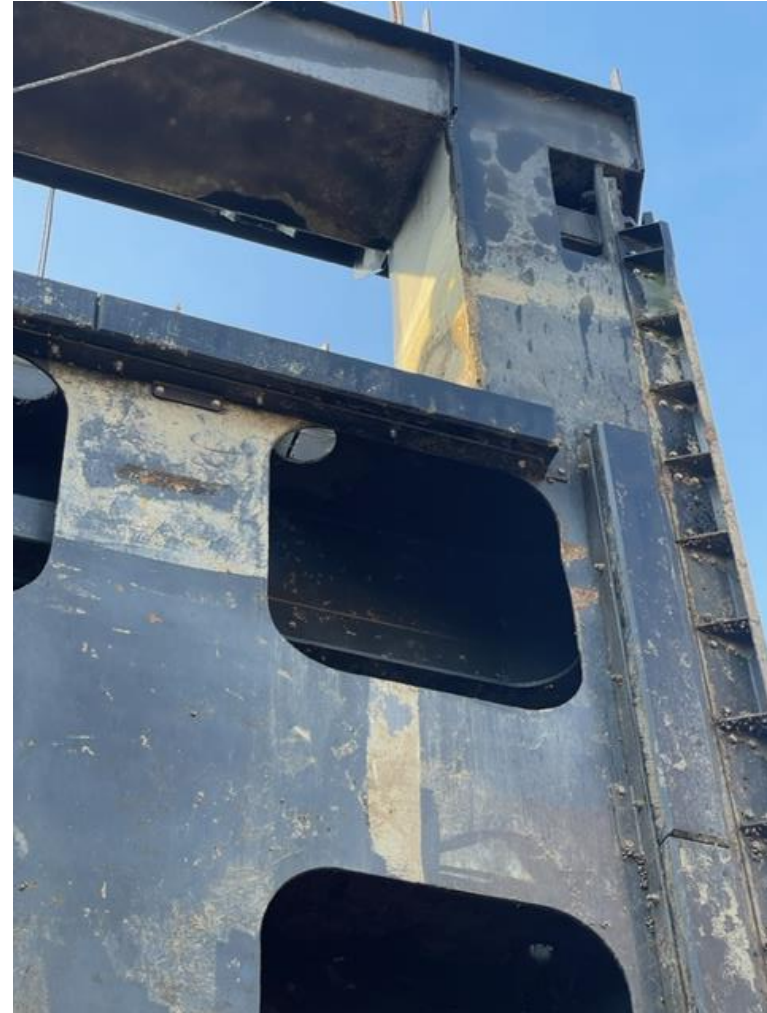
Vue du vantail rive droite (face renforts), idem pour la rive gauche
