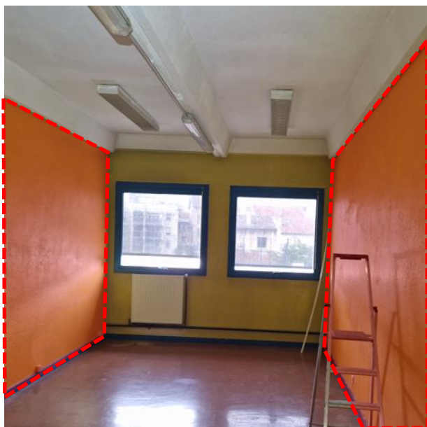
Illustration 14 : Cloisons pouvant être démolies dans les pièces courantes
