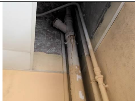
Photo n° PhA023 Localisation : 1er étage - Sanitaire 2 Ouvrage : 6 - Conduits et accessoires intérieurs - Conduits de fluides (air, eau, vapeur, fumée, échappement, autres fluides) Partie d'ouvrage : Conduit en fontes Description : Conduit en fontes
