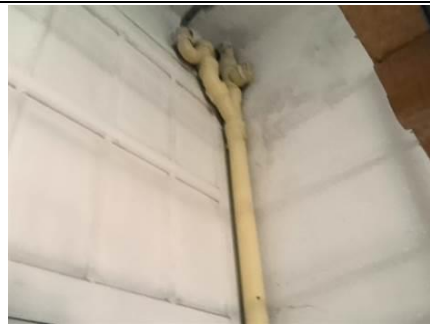
Photo n° PhA008 Localisation : Rez de chaussée - Pièce 10 Ouvrage : 6 - Conduits et accessoires intérieurs - Conduits de fluides (air, eau, vapeur, fumée, échappement, autres fluides) Partie d'ouvrage : Conduit en fontes Description : Conduit en fontes
