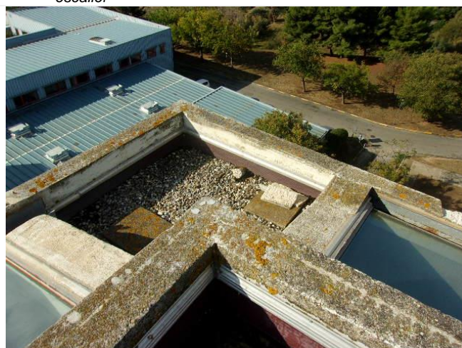
Composant : Peinture ou enduit 165 (N) enduit maçonné acrotères
