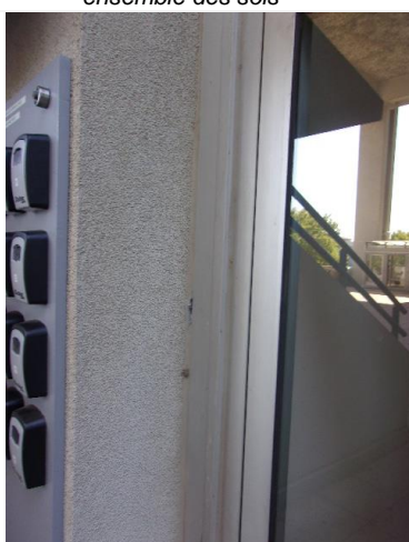
Composant : Joint de vitrage / menuiserie 84 (N) gris souple finition entre menuiseries et maçonnerie en façades
