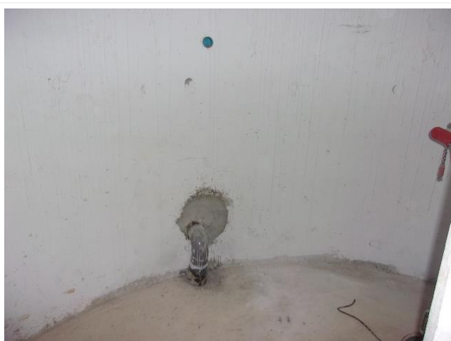
Composant : Rebouchages de trémies 207 (N) enduit gris rebouchage pénétration sous escalier
