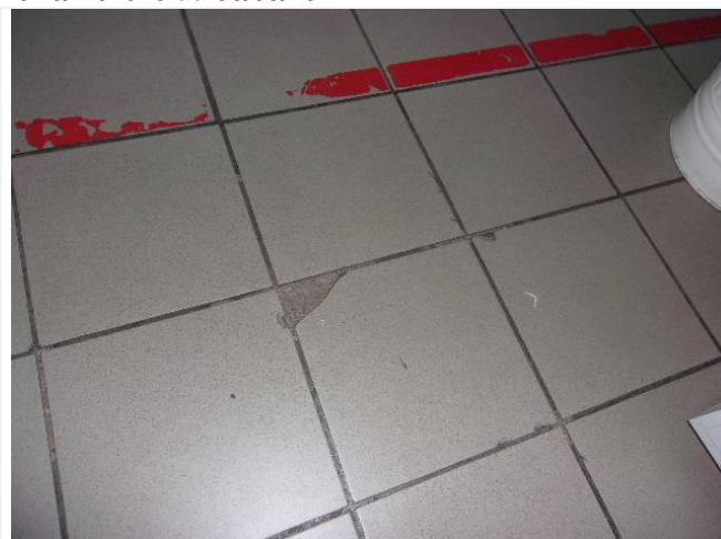
Composant : Colles des carrelages 80 (N) type ciment-colle Sol pc sécurité
