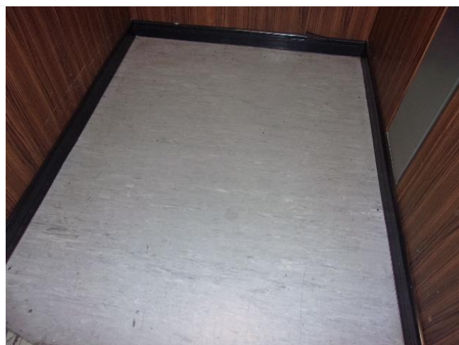
Composant : Les plastique avec sous couche 6 (N) souple + colle sol cabine ascenseur
