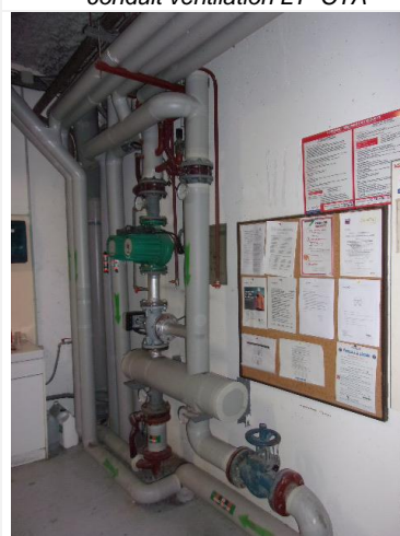
Composant : Joints de chaudière et de conduit 219 (N) remplacés en 2018 divers brides de la sous station
