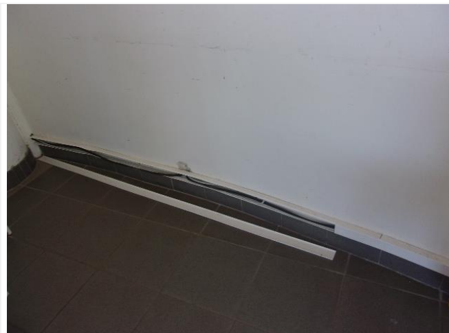
Composant : Colles des carrelages 108 (N) sur plinthes faïence grise pourtour hall amphithéâtre
