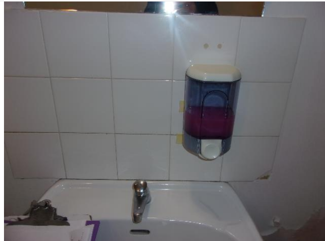
Composant : Colles des carrelages 71 (N) sur faïences 15x15 crédence lavabo des sanitaires
