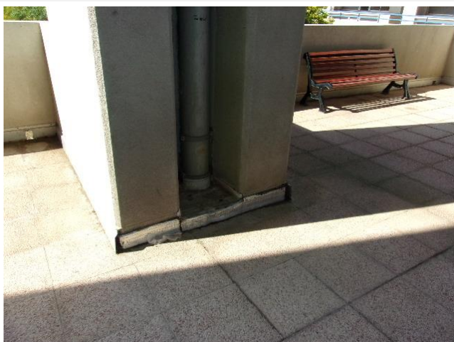
Composant : Revêtements et colles d'étanchéité 215 (N) type PAXALU relevé d'étanchéité en pied de façade (ancien mur d'escalade) et poteaux
