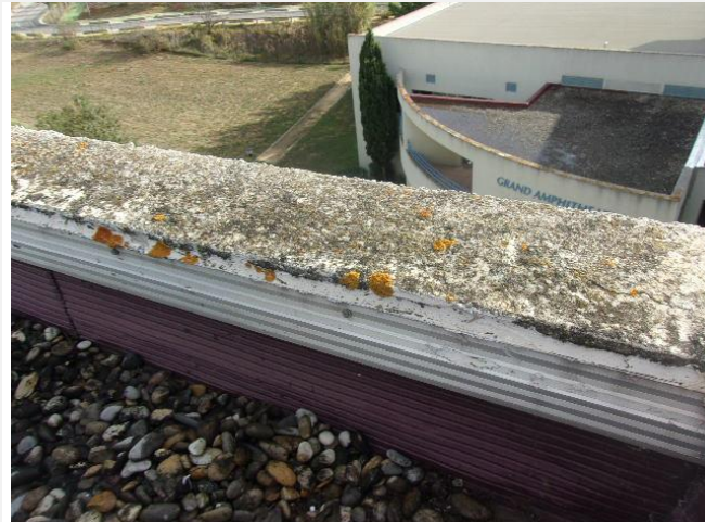
Composant : Joints de panneaux (cloisons, gaines) 151 (N) blanc finitions relevés étanchéité des acrotères
