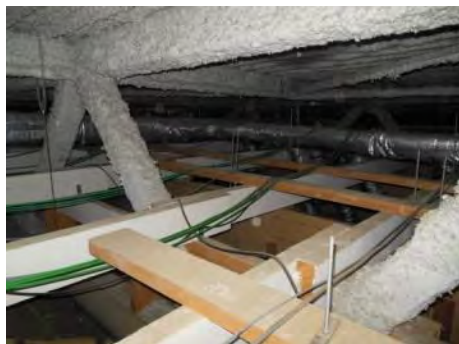
Photo n° 1 : poutre en treillis
