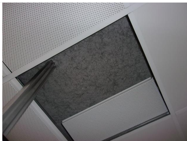
Composant : Flocage 64 (N) minérale postérieur à 1980 en plénum du faux-plafond de l'extension de la salle serveurs
