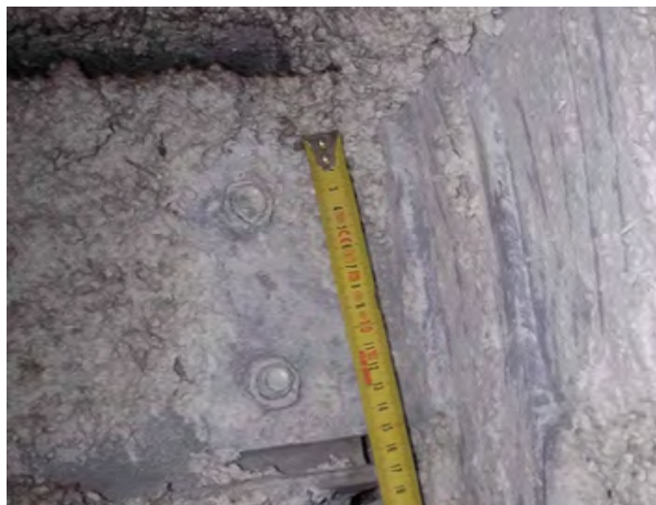
Photo 2: Fixation panne sur poutre
