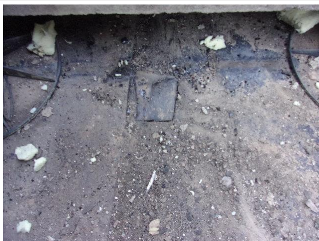
Composant : Revêtements et colles d'étanchéité 47 (N) bitumineux étanchéité bicouche en terrasse sous dalles sur plots
