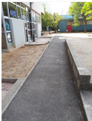
Composant : Revêtements de sols routiers 134 (N) bitumineux sol cheminement FABLAB
