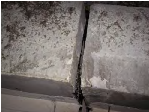
Photo n° 16 : Joint de dilatation côté Nord
