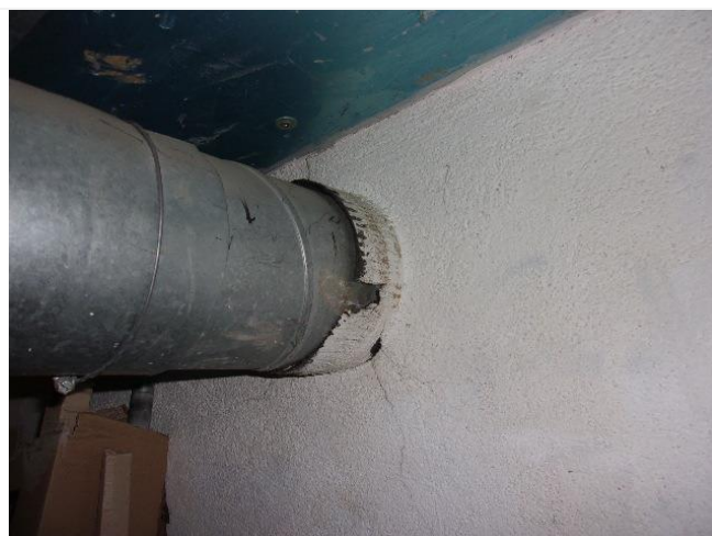
Composant : Revêtements bitumineux 193 (N) en bandes et peinture fourreaux pénétrations voile béton LT CTA
