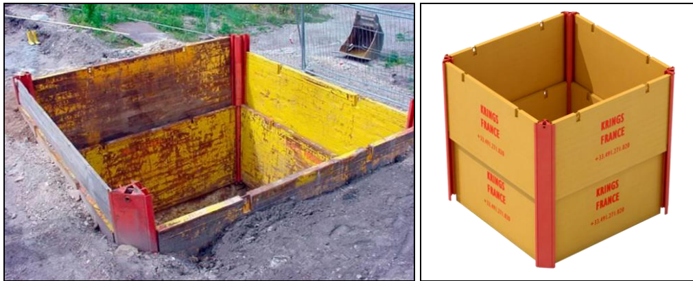
Figures 12 et 13 : exemple de blindage coulissant.
