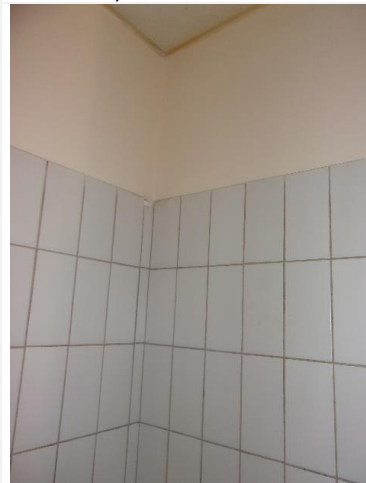
Composant : Colles des carrelages 82 (N) sur faïences blanche murs sanitaires pc sécurité
