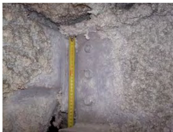
Photo n° 13 : Fixation panne n°2 sur poutre
