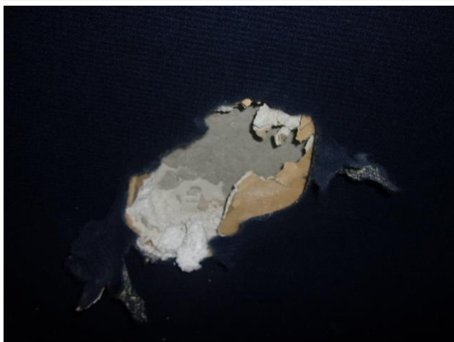
Composant : Colle 184 (N) blanche plots sous doublages murs amphithéâtre
