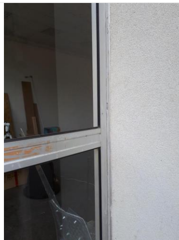
Composant : Joint de vitrage / menuiserie 132 (N) souple gris joint de finition entre menuiseries et façades FABLAB
