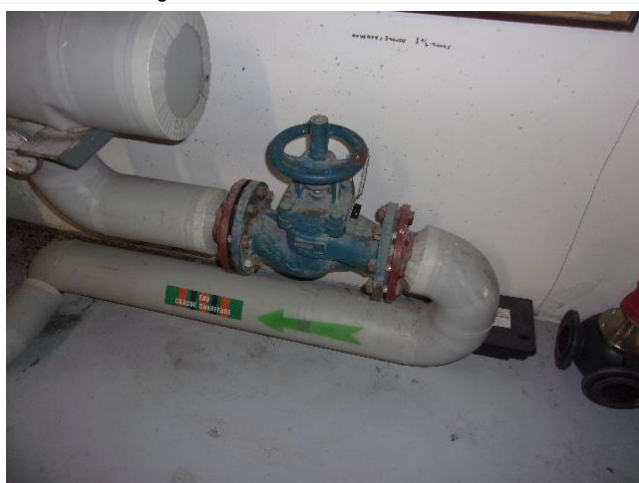
Composant : Joints de chaudière et de conduit 202 (a) joint beige brides vanne ancienne bleu de la sous-station
