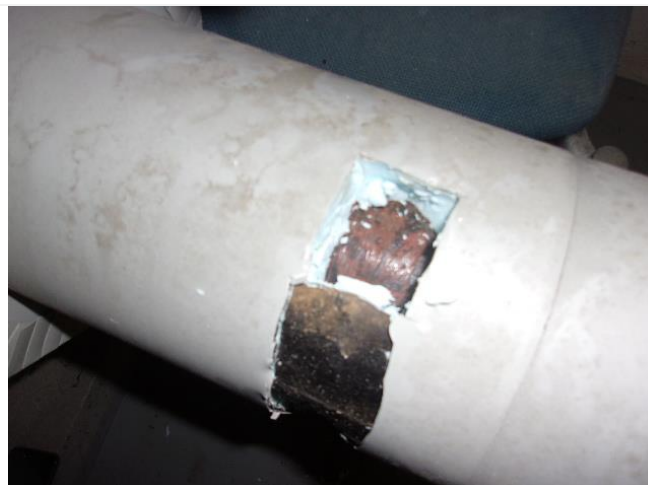
Composant : Colle 201 (N) bitumineuse coques calorifuges/canalisations réseaux eaux glacées
