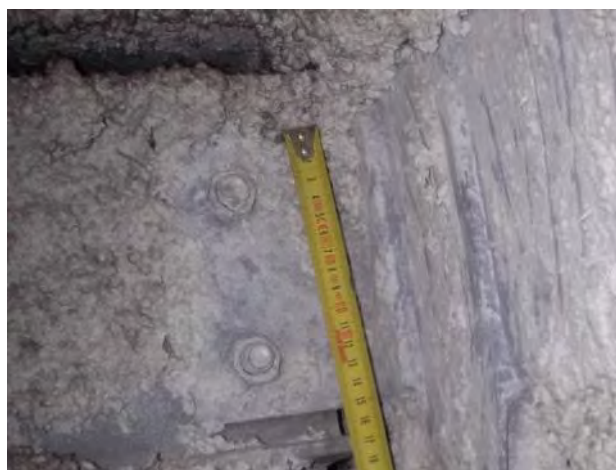
Photo n° 11 : Fixation panne n°1 sur poutre
