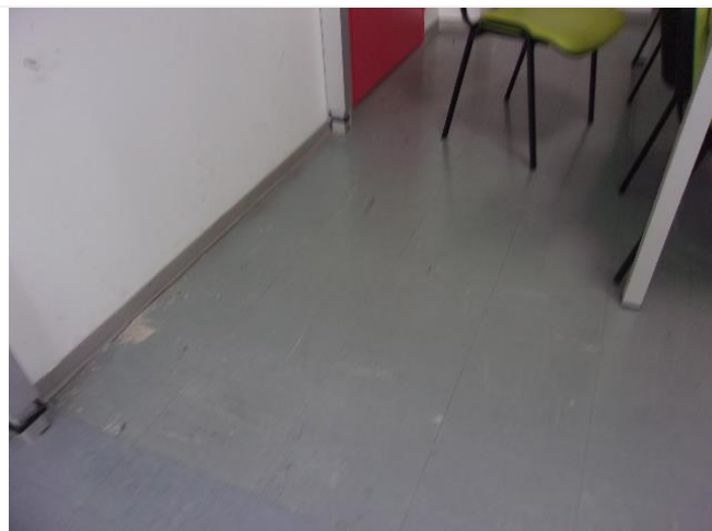
Composant : Dalle de sol plastique 48 (N) grise sols salles
