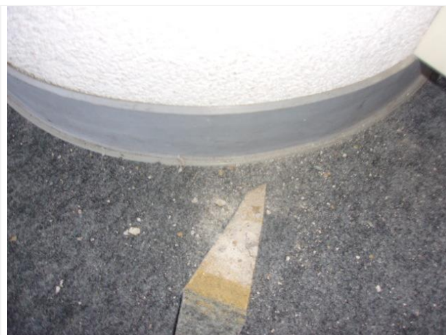
Composant : Ragréege 14 (N) gris et colle jaune sous sols moquette
