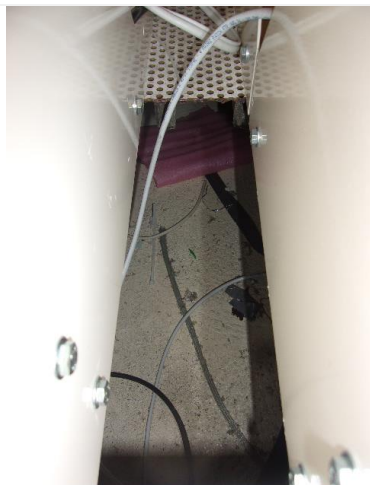
Composant : Chape maigre 69 (N) béton et peinture sol extension local serveurs
