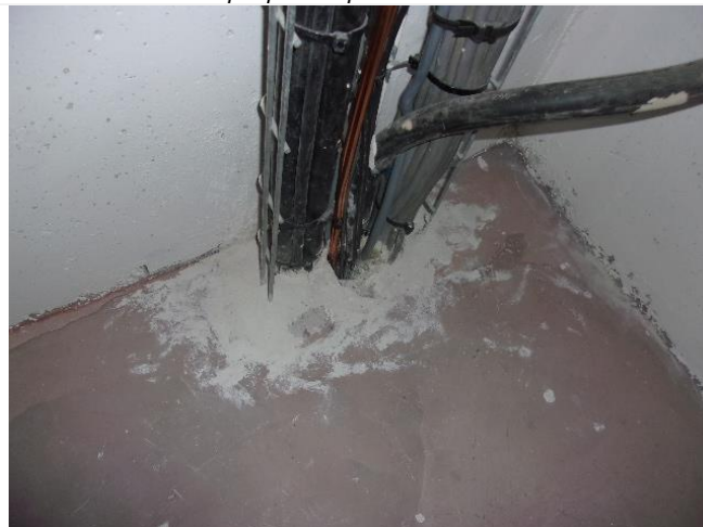
Composant : Rebouchages de trémies 172 (N) plâtreux réservation en plancher du LT
