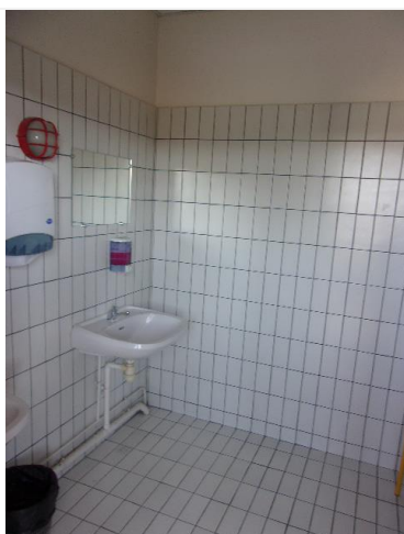
Composant : Colles des carrelages 20 (N) sur faïences blanche Murs sanitaires
