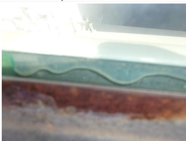
Composant : Joints de panneaux (cloisons, gaines) 164 (N) souple transparent entre vitrages et parcloles des verrières
