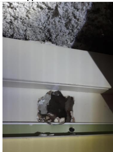
Composant : Flocage 127 (N) minérale postérieur à 1980 en plénum du faux-plafond
