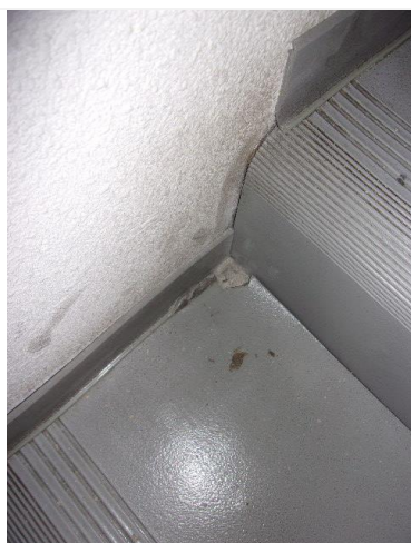
Composant : Ragréege 10 (N) et colle sol marches escalier sous lés plastique
