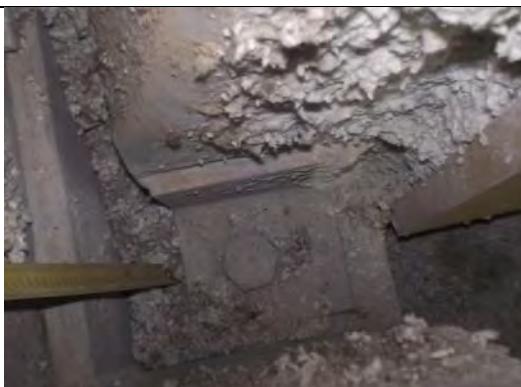
Photo n° 9 : fixation de la poutre sur appui Appui SUD – file n° ②
