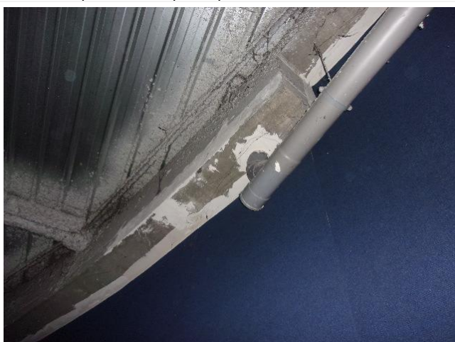
Composant : Peinture ou enduit 187 (N) enduit plâtreux cueillis entre poutres et voiles amphithéâtre
