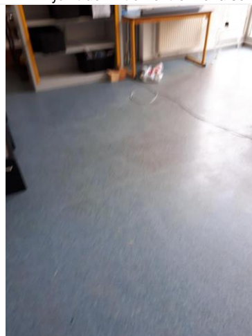
Composant : Les plastique avec sous couche 129 (N) thermosoudés bleu, colle jaune et ragréage rose et gris sols du FABLAB
