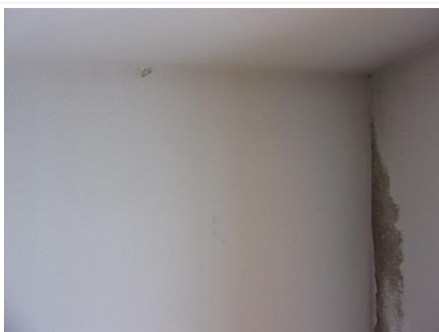
Composant : Joints de panneaux (cloisons, gaines) 176 (N) bandes plâtrées et enduit doublages cage escalier
