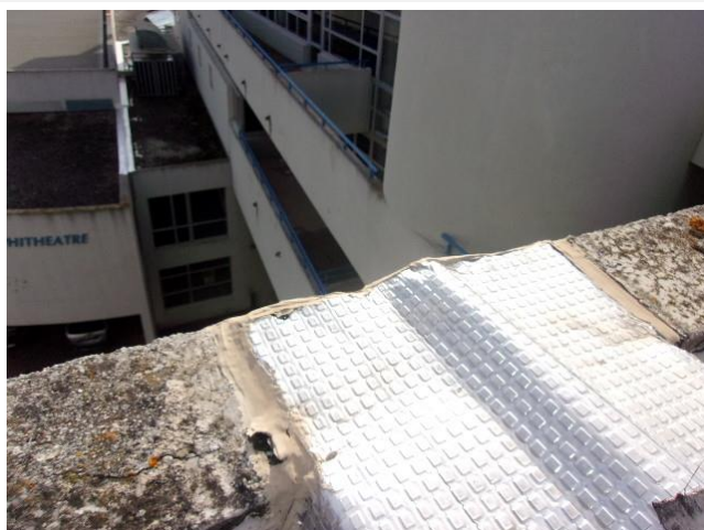
Composant : Joints de panneaux (cloisons, gaines) 150 (N) souple beige et bitume finition couvre joint dilatation
