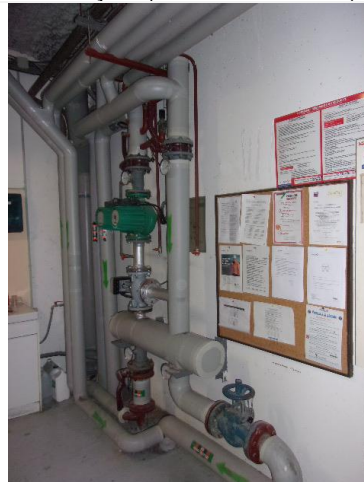
Composant : Enveloppe de calorifugeage 203 (N) pvc sur coques calorifuge
