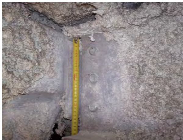
Photo 2: Fixation panne sur poutre
