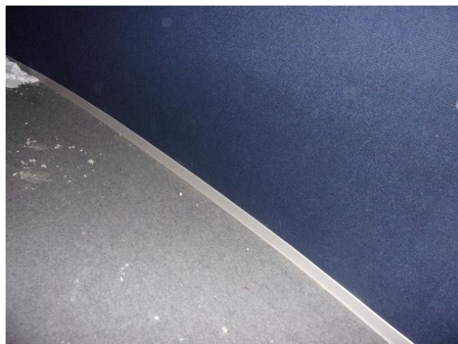
Composant : Colle 185 (N) jaune et plinthes pvc pourtour amphithéâtre
