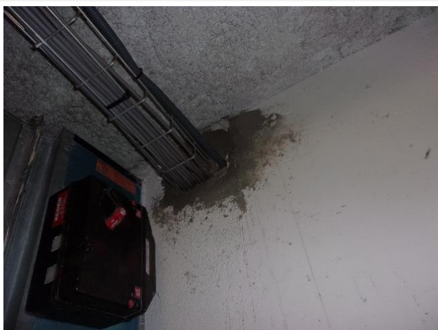
Composant : Rebouchages de trémies 194 (N) enduit rebouchage pénétrations voiles béton LT CTA
