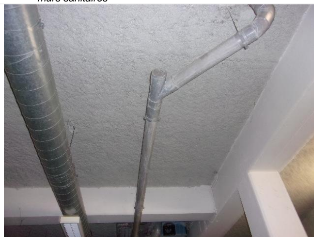
Composant : Flocage 136 (N) minérale postérieur à 1980 plafonds locaux techniques et vinci
