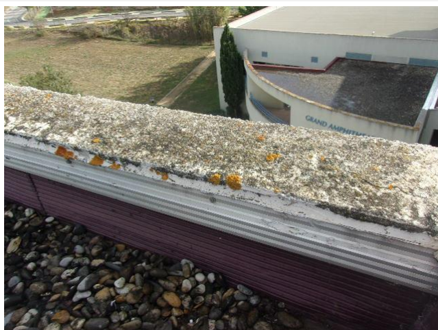
Composant : Peinture ou enduit 158 (N) enduit maçonné acrotères
