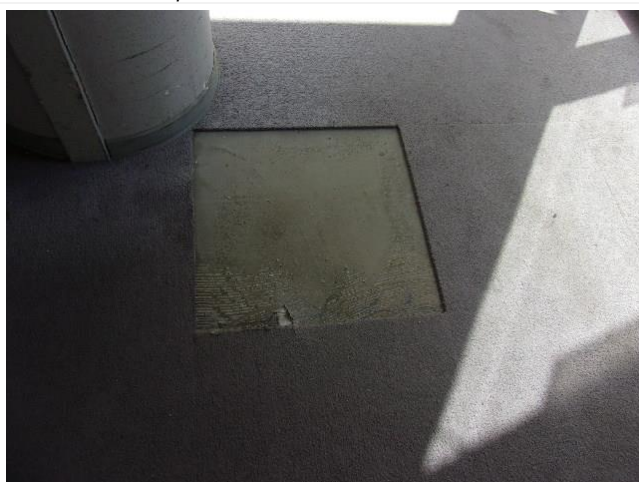
Composant : Ragréage 87 (N) et colle sous dalles moquette sols d'une partie des salles
