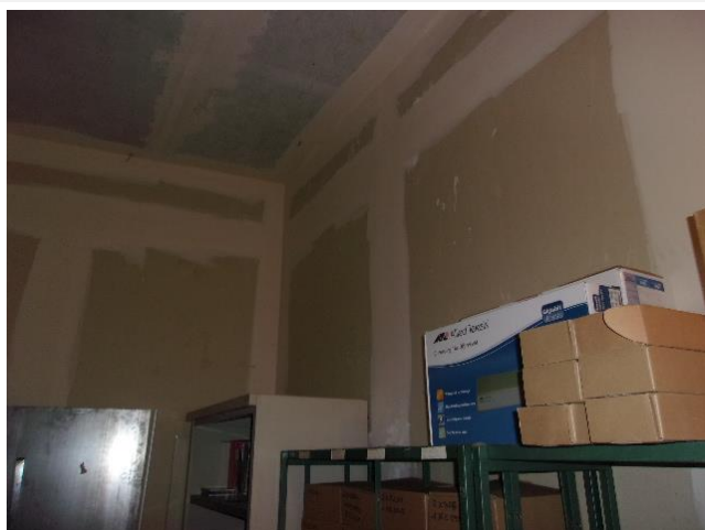
Composant : Joints de panneaux (cloisons, gaines) 189 (N) bandes plâtrées cloisons plaques de plâtre local réserve informatique
