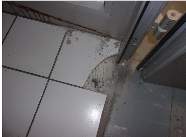
Composant : Colles des carrelages 55 (N) blanche sur colle noire sol du sanitaire
