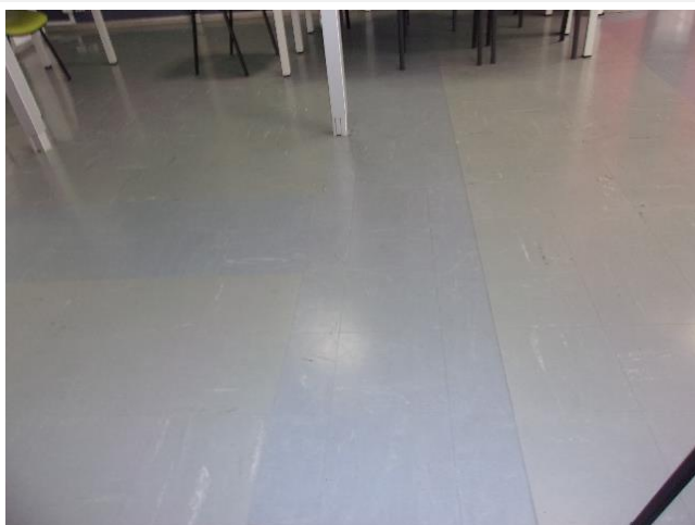
Composant : Dalle de sol plastique 50 (N) bleu sols salles
