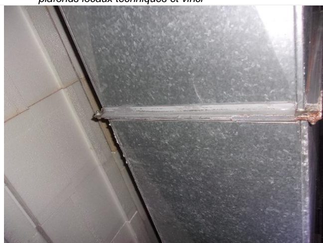
Composant : Joints de chaudière et de conduit 96 (N) gris souple gaines ventilation en vide-sanitaire de l'amphithéâtre (idem dans local Vinci)
