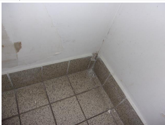
Composant : Colles des carrelages 70 (N) sur plinthes faïence grise pourtour sanitaires
