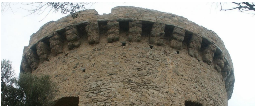
Figure 25 Etat des mâchicoulis après travaux (photo du Conservatoire du littoral datant de 2005)
