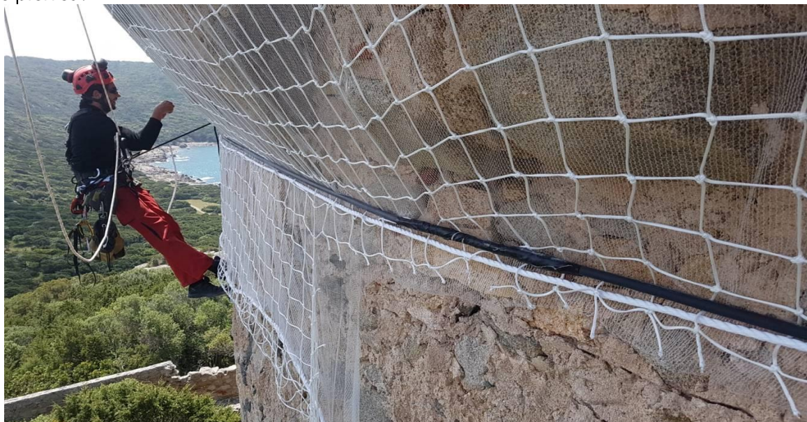
Figure 28 Intervention de l'entreprise Apex sur la tour de Campomoro (photographie de l'entreprise)
