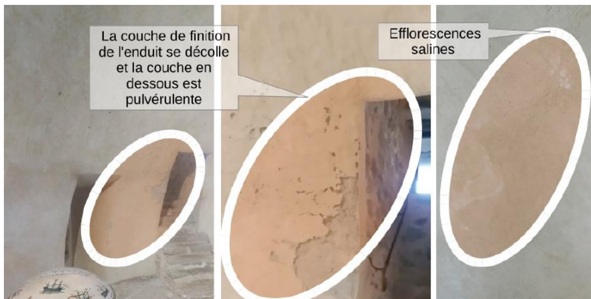
Figure 14 Extrait du rapport d'expertise concernant les enduits intérieurs (THOUVENIN, 2025)
