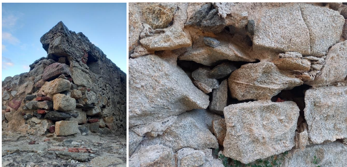
Figure 13 Photographies des remparts aux joints usés voire disparus et aux moellons de granit érodés
