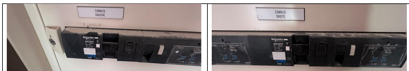
Disjoncteur « CANALIS GAUCHE » NG125N C100A
