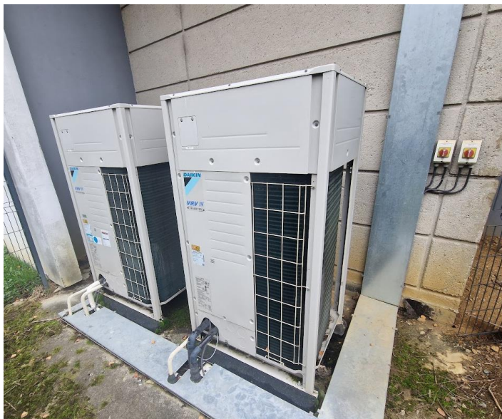
Figure 1 : Groupes extérieurs VRV : NB : les 2 unités sont connectées entre elles, elles ne sont pas indépendantes
