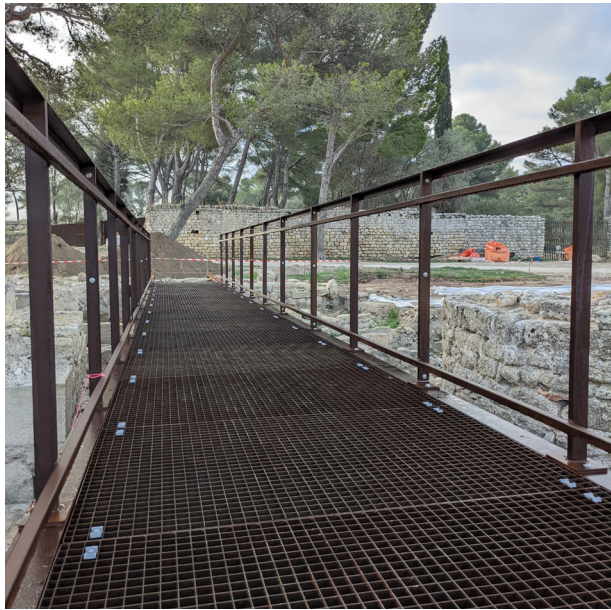
Exemple de passerelle en caillebotis
