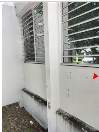
Matériaux : ZPSO-027 Prélèvement : P027 Description : Peinture sur béton prefa blanc Localisation : Façade gauche extension ar Résultat : Absence d'amiante
