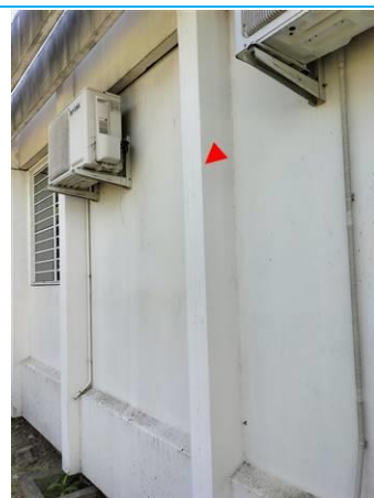
Matériaux : ZPSO-020 Prélèvement : P020 Description : Peinture sur béton poutre verticale blanche Localisation : Façade gauche Résultat : Absence d'amiante
