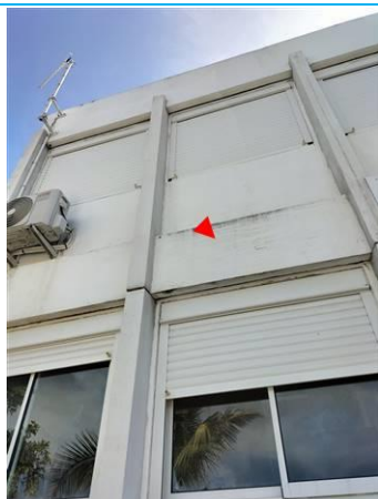
Matériaux : ZPSO-013 Prélèvement : P013 Description : Peinture sur béton moulurage blanc Localisation : 1er étage - Façade AV Résultat : Absence d'amiante
