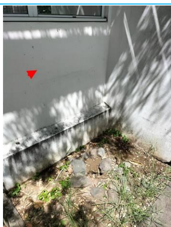
Matériaux : ZPSO-041 Prélèvement : P041 Description : Peinture sur béton prefa blanc Localisation : Façade AR extention Résultat : Absence d'amiante
