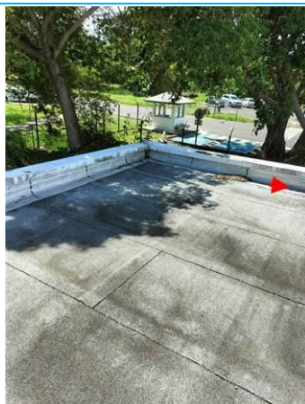
Matériaux : ZPSO-081 Prélèvement : P081 Description : Relevé : accrotères verale alu Localisation : Rez de chaussée - Toiture terrasse Résultat : Absence d'amiante
