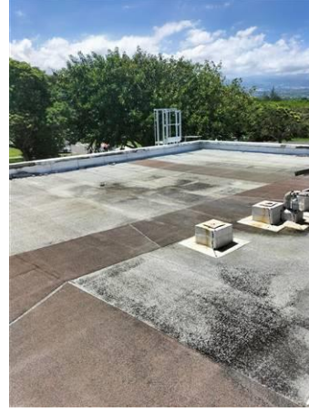
Matériaux : ZPSO-086 Prélèvement : P086 Description : Partie plane : revêtement bitumineux (bandes, lés...) verte Localisation : 1er étage - Toiture terrasse Résultat : Absence d'amiante
