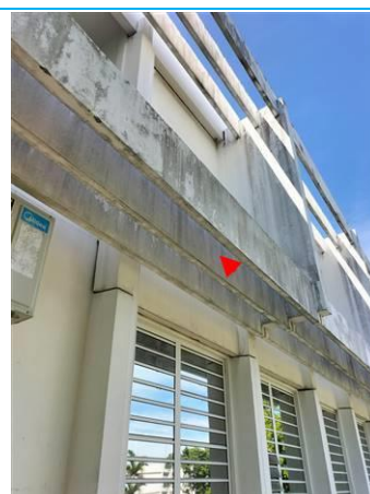
Matériaux : ZPSO-030 Prélèvement : P030 Description : Peinture sur béton brise soleil beton blanc Localisation : Façade gauche extension ar Résultat : Absence d'amiante
