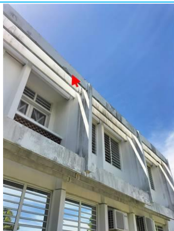
Matériaux : ZPSO-039 Prélèvement : P039 Description : Peinture sur béton brise soleil en beton blanc Localisation : 1er étage - Façade Gauche Résultat : Absence d'amiante
