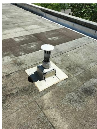
Matériaux : ZPSO-085 Prélèvement : P085 Description : -equerre d'etancheitée edicule de cheminee Localisation : Rez de chaussée - Toiture terrasse Résultat : Absence d'amiante
