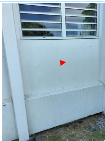
Matériaux : ZPSO-019 Prélèvement : P019 Description : Peinture sur béton prefa blanc Localisation : Façade gauche Résultat : Absence d'amiante
