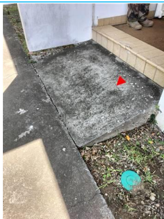
Matériaux : ZPSO-021 Prélèvement : P021 Description : Ragréage beton rampe d'accès Localisation : Façade gauche Résultat : Absence d'amiante
