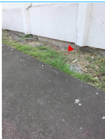
Matériaux : ZPSO-017 Prélèvement : P017 Description : Peinture sur béton sous bassement Localisation : Façade gauche Résultat : Absence d'amiante
