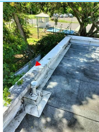
Matériaux : ZPSO-082 Prélèvement : P082 Description : chapeau d'accrotere blanc Localisation : Rez de chaussée - Toiture terrasse Résultat : Présence d'amiante
