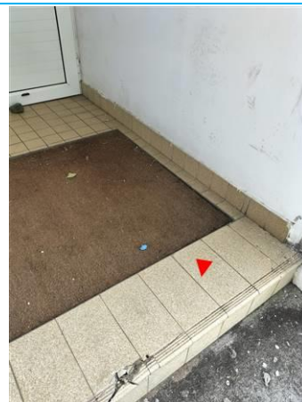
Matériaux : ZPSO-022 Prélèvement : P022 Description : Colle de carrelage moucheté beige accès gauche Localisation : Façade gauche Résultat : Absence d'amiante
