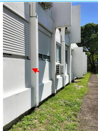
Matériaux : ZPSO-058 Prélèvement : P058 Description : Peinture sur béton poutre verticale blanche Localisation : Façade Droite Résultat : Absence d'amiante
