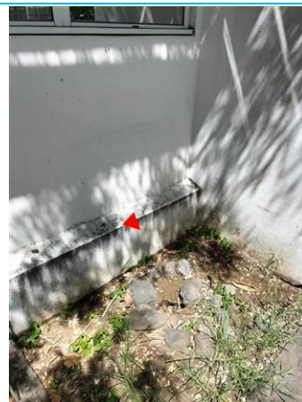
Matériaux : ZPSO-040 Prélèvement : P040 Description : Peinture sur béton moulurage blanc Localisation : Façade AR extention Résultat : Absence d'amiante
