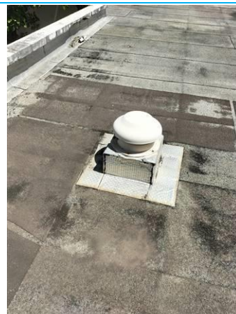
Matériaux : ZPSO-084 Prélèvement : P084 Description : -equerre d'etancheitée edicule de ventilation Localisation : Rez de chaussée - Toiture terrasse Résultat : Absence d'amiante
