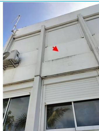
Matériaux : ZPSO-014 Prélèvement : P014 Description : Peinture sur béton prefa blanc Localisation : 1er étage - Façade AV Résultat : Absence d'amiante
