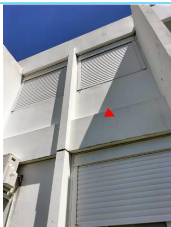
Matériaux : ZPSO-059 Prélèvement : P059 Description : Peinture sur béton moulurage blanc Localisation : 1er étage - Façade droite Résultat : Absence d'amiante
