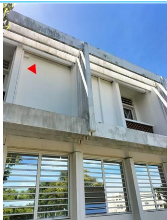
Matériaux : ZPSO-037 Prélèvement : P037 Description : Peinture sur béton prefa blanc Localisation : 1er étage - Façade Gauche Résultat : Absence d'amiante
