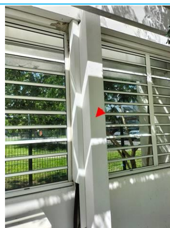
Matériaux : ZPSO-042 Prélèvement : P042 Description : Peinture sur béton poutre verticale blanche Localisation : Façade AR extention Résultat : Absence d'amiante
