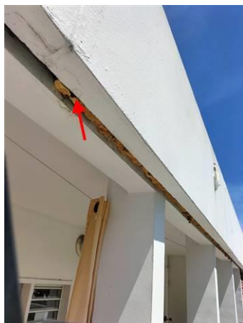
Matériaux : ZPSO-077 Prélèvement : P077 Description : -joint de moulurage haut Localisation : 1er étage - Façade AR Résultat : Absence d'amiante
