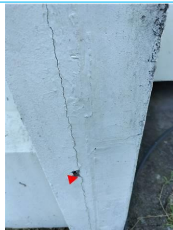
Matériaux : ZPSO-032 Prélèvement : P032 Description : Joint de dilatation Localisation : Façade AV Résultat : Absence d'amiante
