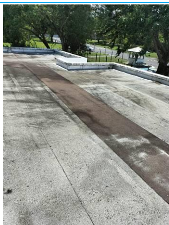
Matériaux : ZPSO-079 Prélèvement : P079 Description : Partie plane : revêtement bitumineux (bandes, lés...) verte Localisation : Rez de chaussée - Toiture terrasse Résultat : Absence d'amiante
