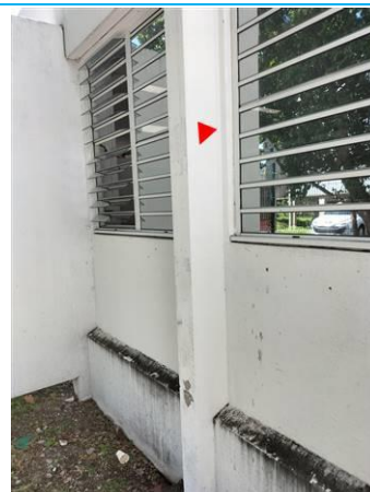
Matériaux : ZPSO-028 Prélèvement : P028 Description : Peinture sur béton poutre verticale blanche Localisation : Façade gauche extension ar Résultat : Absence d'amiante
