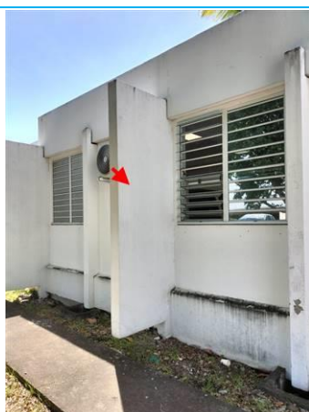
Matériaux : ZPSO-029 Prélèvement : P029 Description : Peinture sur béton blanc mur separatif Localisation : Façade gauche extension ar Résultat : Absence d'amiante
