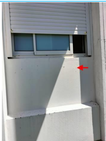
Matériaux : ZPSO-057 Prélèvement : P057 Description : Peinture sur béton prefa blanc Localisation : Façade Droite Résultat : Absence d'amiante
