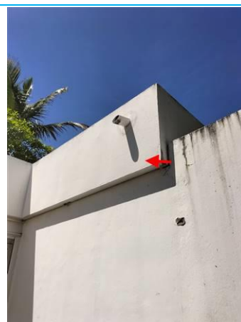
Matériaux : ZPSO-034 Prélèvement : P034 Description : Peinture sur béton moulage haut blanc Localisation : Façade gauche extension ar Résultat : Présence d'amiante
