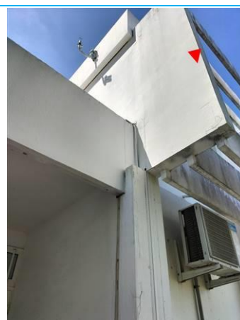
Matériaux : ZPSO-036 Prélèvement : P036 Description : Peinture sur béton mur separatif blanc Localisation : 1er étage - Façade Gauche Résultat : Absence d'amiante
