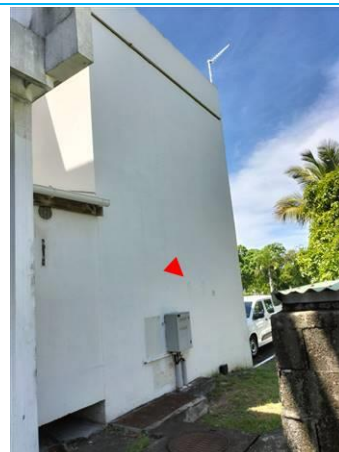
Matériaux : ZPSO-016 Prélèvement : P016 Description : Peinture sur béton blanc Localisation : Façade gauche Résultat : Présence d'amiante
