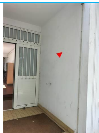
Matériaux : ZPSO-024 Prélèvement : P024 Description : Peinture sur béton blanc Localisation : Façade gauche Résultat : Absence d'amiante
