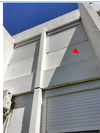
Matériaux : ZPSO-060 Prélèvement : P060 Description : Peinture sur béton prefa blanc Localisation : 1er étage - Façade droite Résultat : Absence d'amiante
