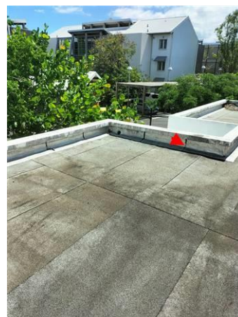
Matériaux : ZPSO-080 Prélèvement : P080 Description : Relevé : accroteres verale alu Localisation : Rez de chaussée - Toiture terrasse Résultat : Absence d'amiante
