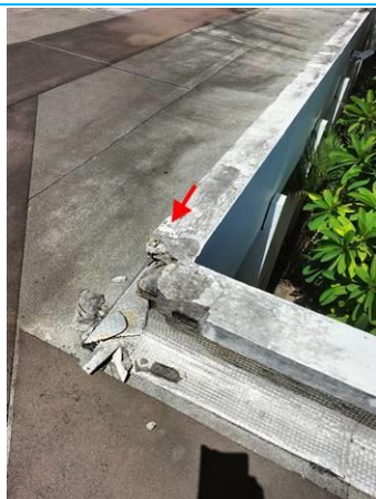
Matériaux : ZPSO-083 Prélèvement : P083 Description : chapeau d'accrotere blanc Localisation : Rez de chaussée - Toiture terrasse Résultat : Présence d'amiante
