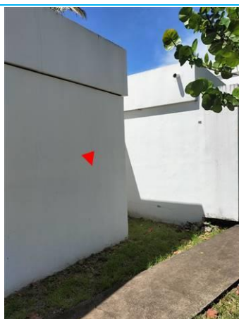
Matériaux : ZPSO-033 Prélèvement : P033 Description : Peinture sur béton blanc Localisation : Façade gauche extension ar Résultat : Absence d'amiante
