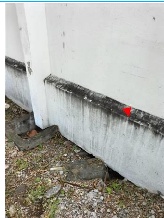
Matériaux : ZPSO-026 Prélèvement : P026 Description : Peinture sur béton moulurage blanc Localisation : Façade gauche extension ar Résultat : Absence d'amiante
