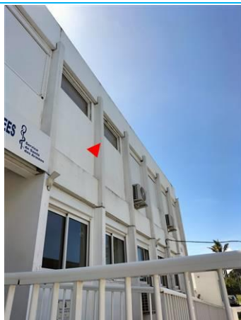
Matériaux : ZPSO-015 Prélèvement : P015 Description : Peinture sur béton poutre verticale blanche Localisation : 1er étage - Façade AV Résultat : Absence d'amiante
